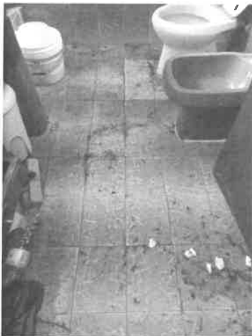
33. Pavimento del bagno
