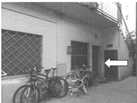
5. Facciata di ingresso
