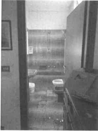
31. Vista del bagno (dal disimpegno)
