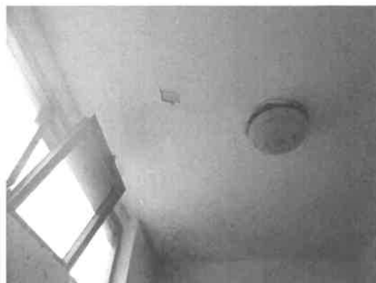
28. Soffitto della cucina
