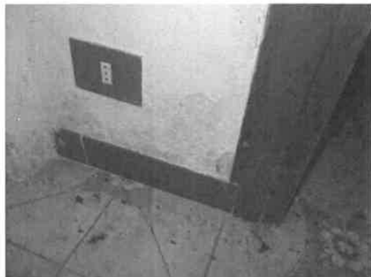
18. Dettaglio della muratura
