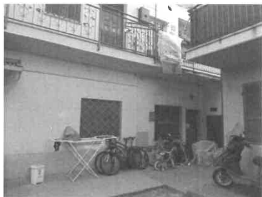
6. Facciata di ingresso
