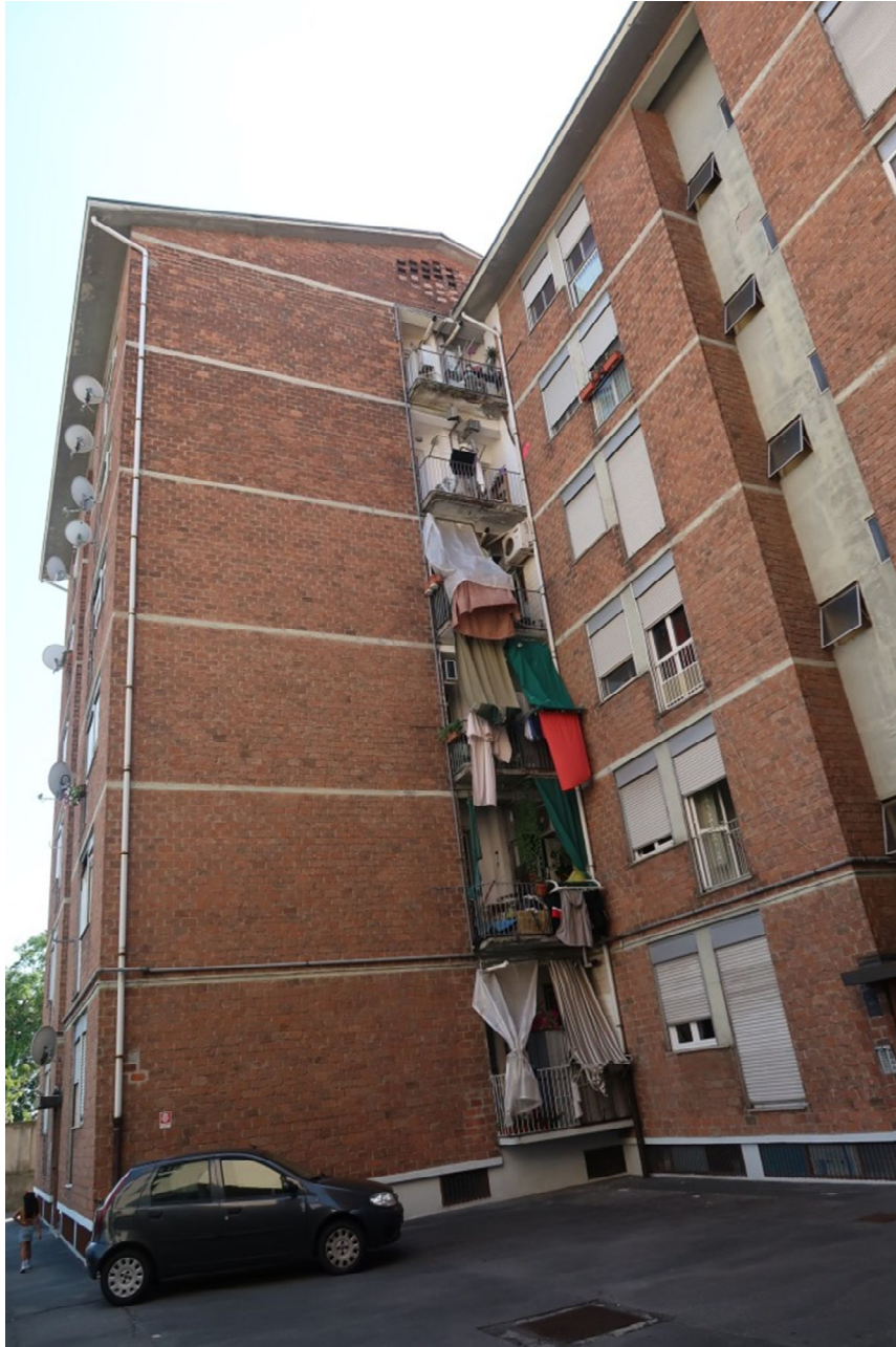
FACCIATA SU CORTILE INTERNO
