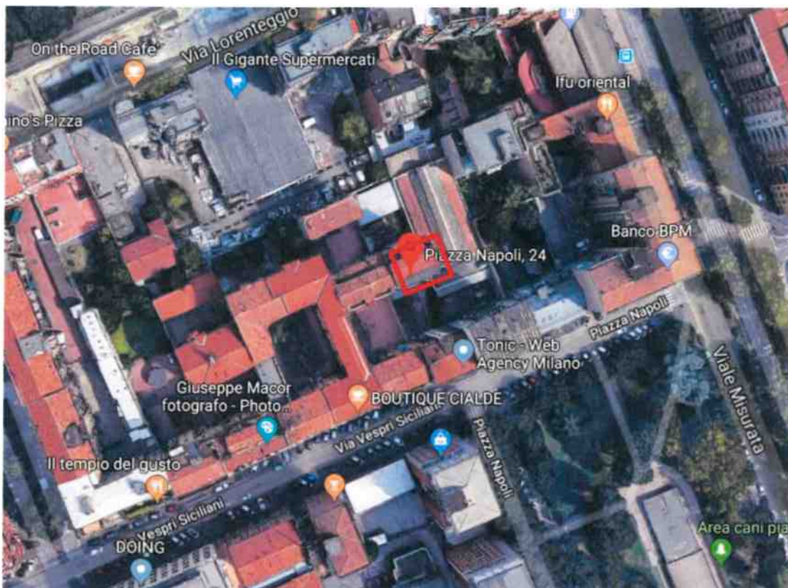
Vista area del fabbricato da Google Maps
