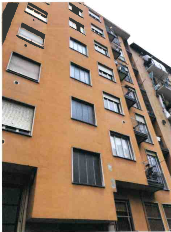
Viste al fabbricato interno dal retro
