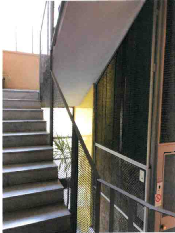
Vista vano scala comune
