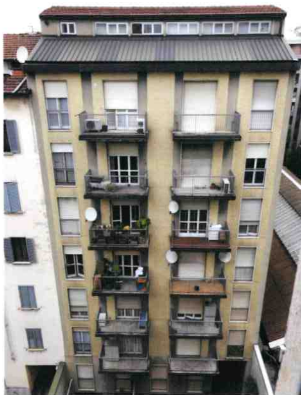
Viste al fabbricato interno
