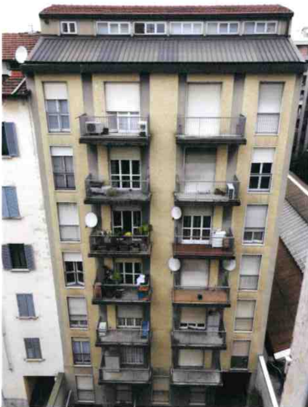
Viste al fabbricato interno
