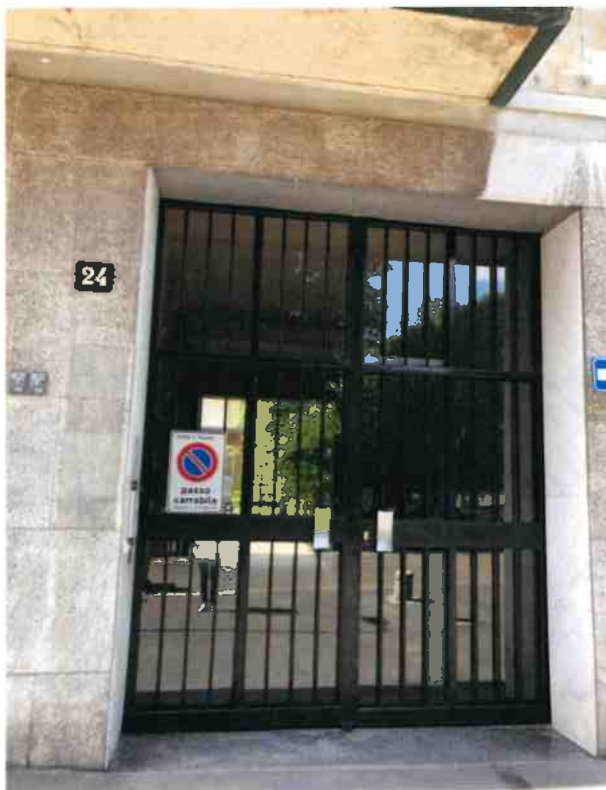
Vista portone di Ingresso civico N.24
