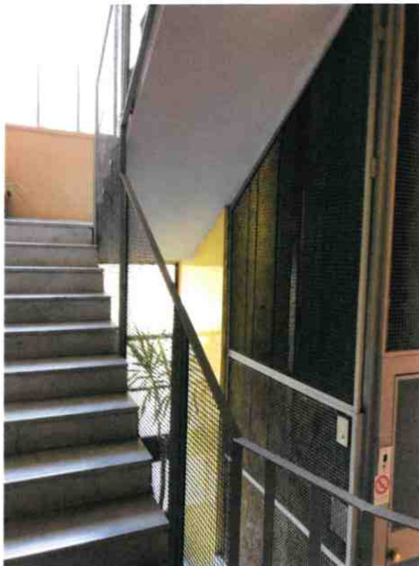
Vista vano scala comune
