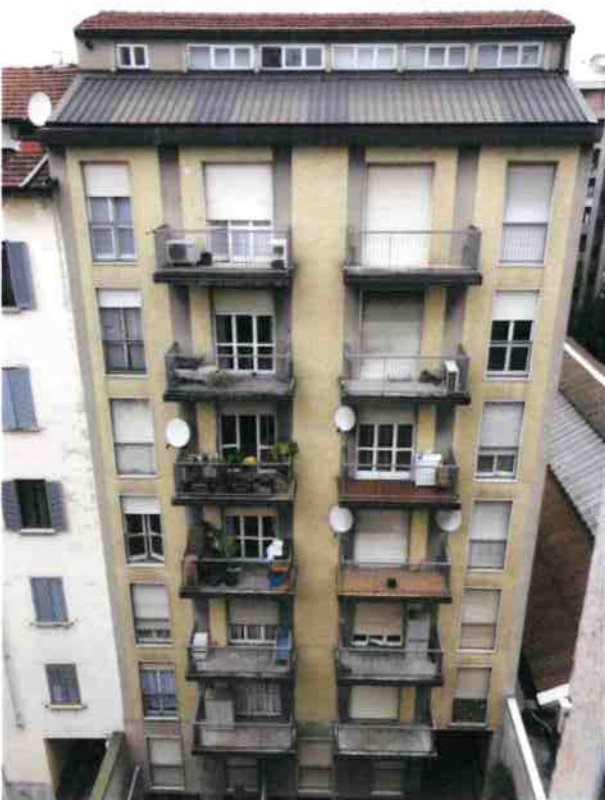
Viste al fabbricato interno
