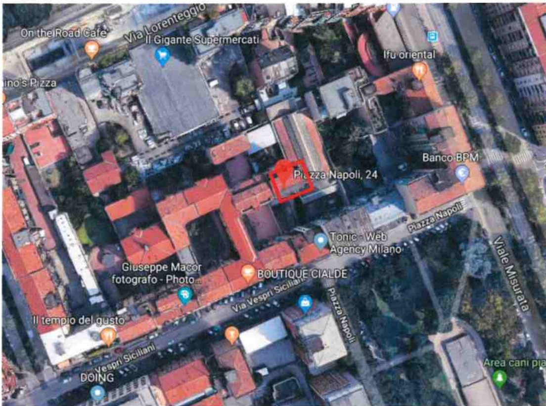
Vista area del fabbricato da Google Maps
