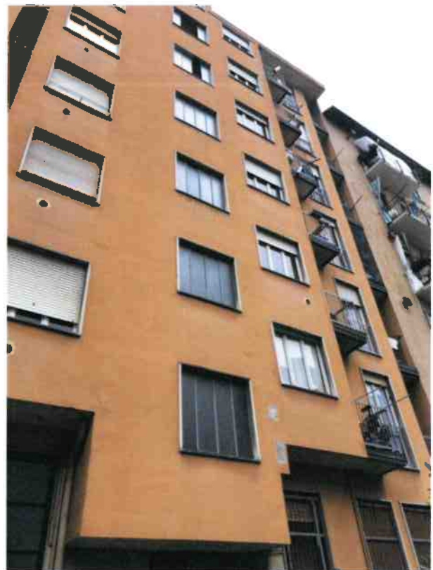
Viste al fabbricato interno dal retro
