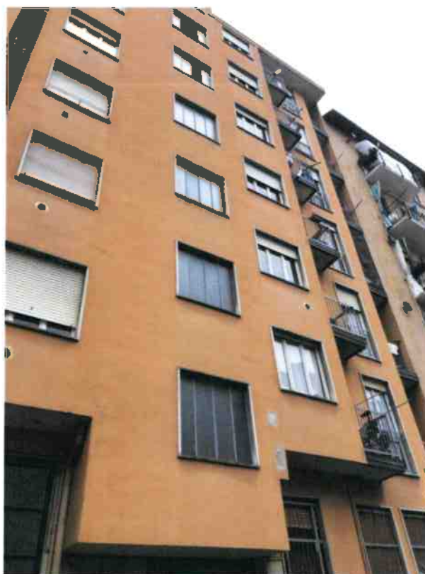
Viste al fabbricato interno dal retro
