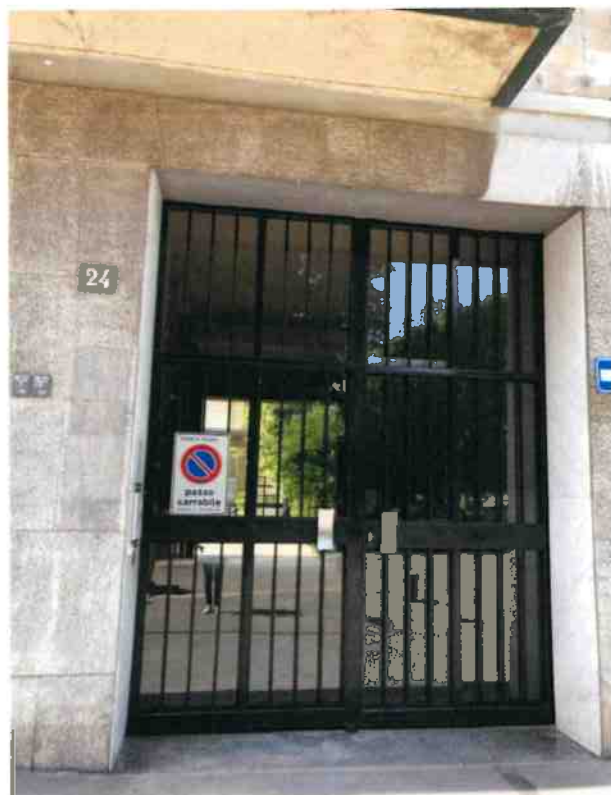
Vista portone di ingresso civico N.24
