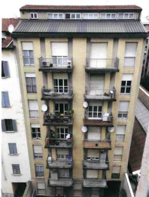
Viste al fabbricato interno
