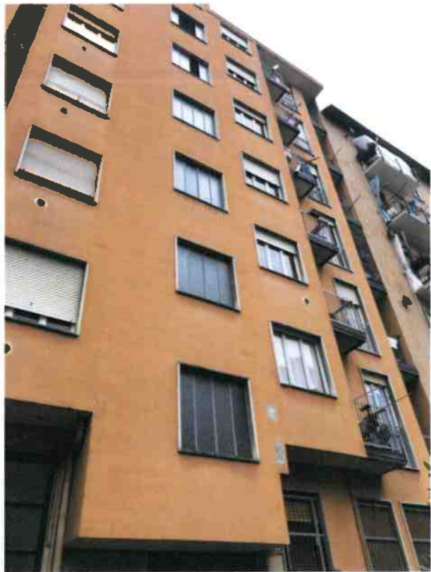
Viste al fabbricato interno dal retro
