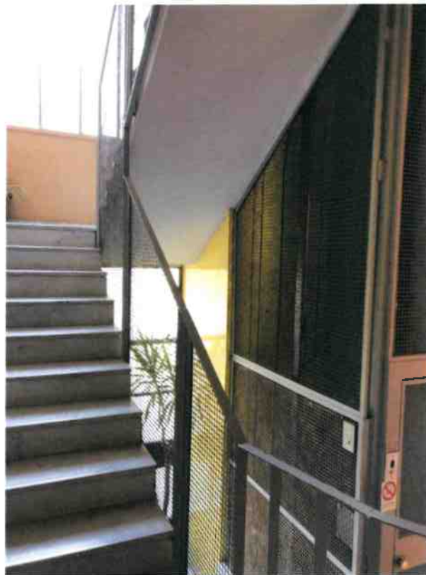
Vista vano scala comune
