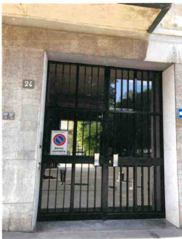
Vista portone di ingresso civico N.24
