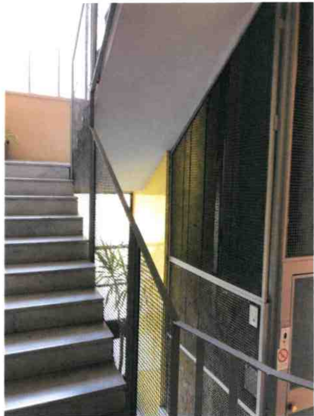
Vista vano scala comune
