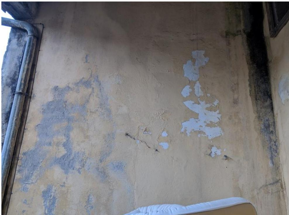
**FOTO 36:** SEGNI DI INFILTRAZIONE (Lato interno)
