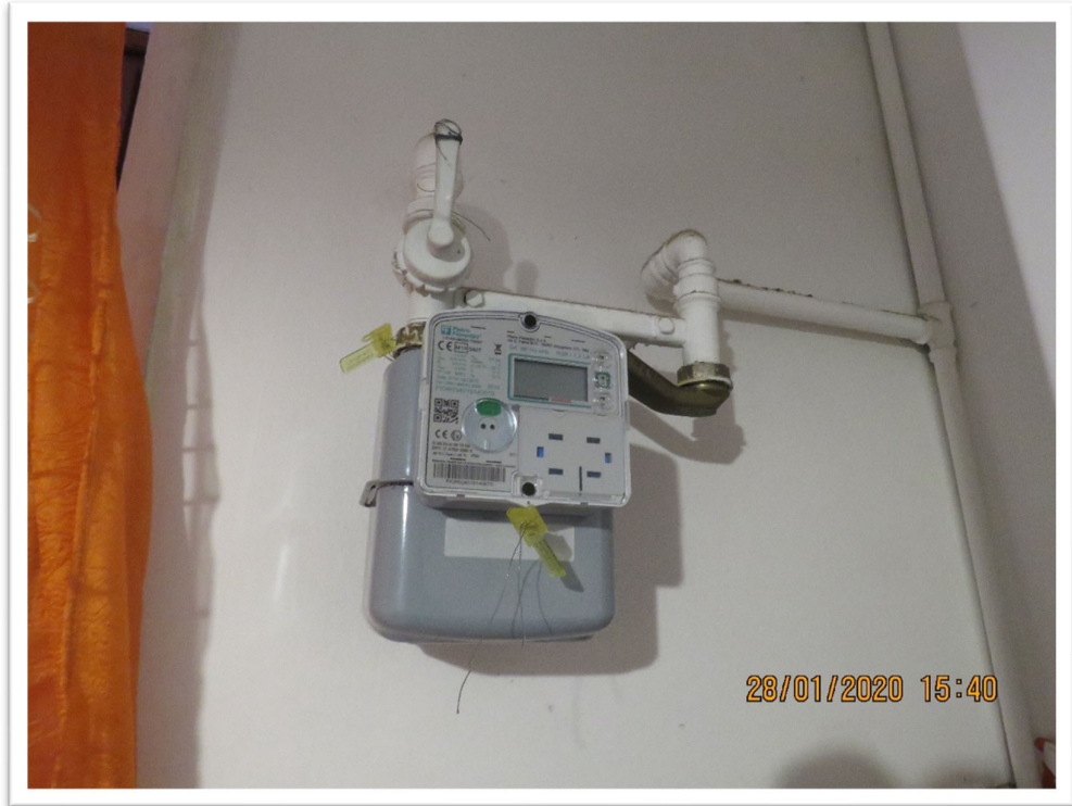
Particolari e corridoio cantine.
