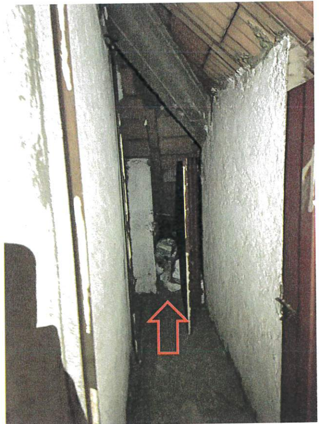
vista vano solaio di pertinenza
