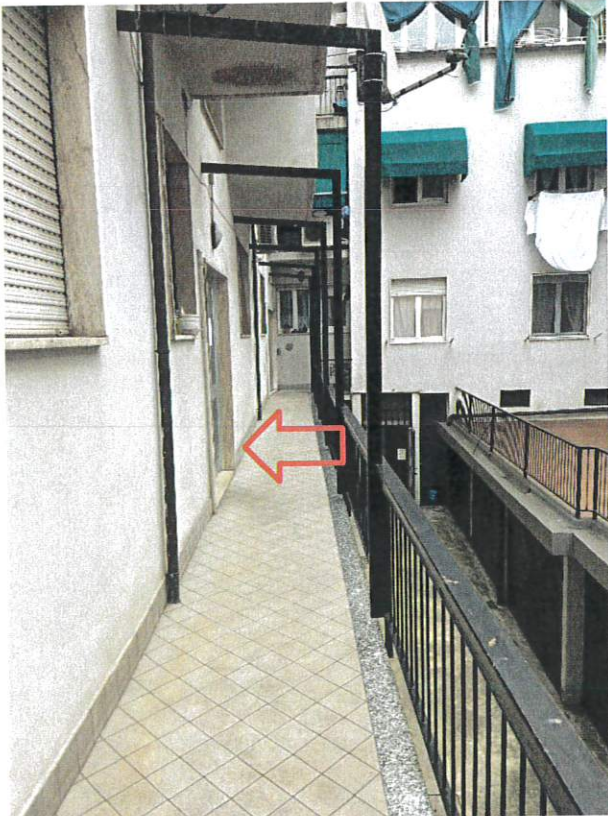
Vista ballatoio interno
