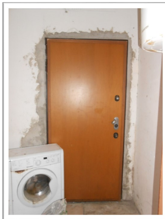
Foto 8 disimpegno e seconda porta d'ingresso
