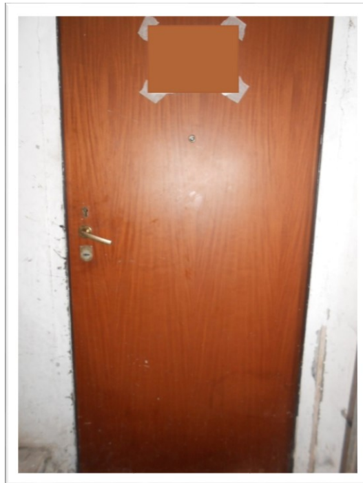
Foto 4 porta ingresso all'immobile
