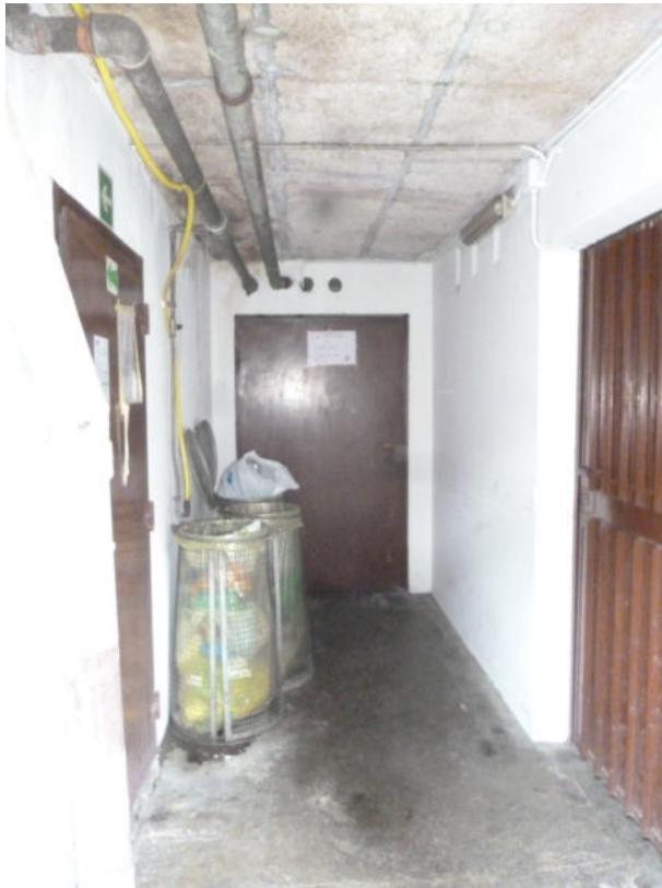
FOTO 16 – Accesso al vano cantina
