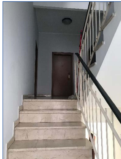
Foto 4 – vano scala comune
