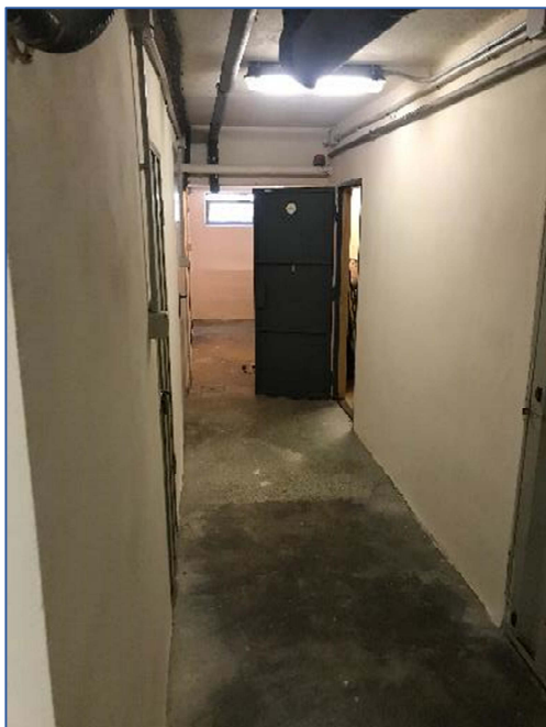
Foto 19 - corridoio comune piano S1
