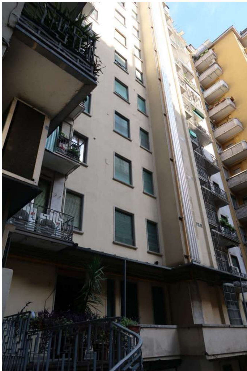
FACCIATA SU CORTILE INTERNO
