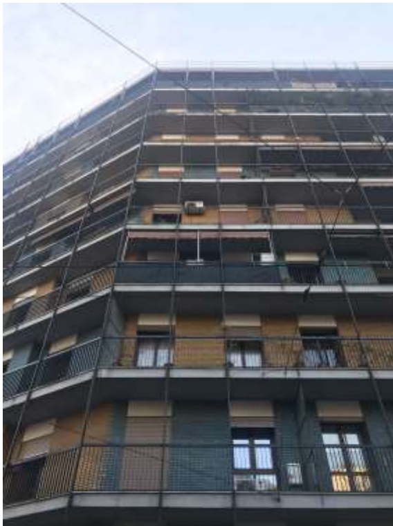
Immagine 3. Dettaglio del prospetto.
