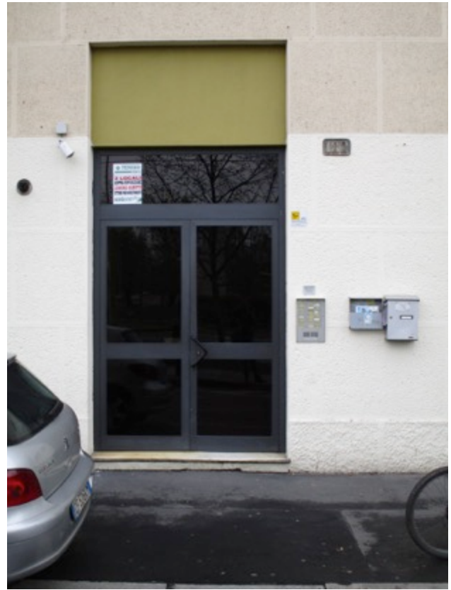
2. Accesso pedonale civico 182
