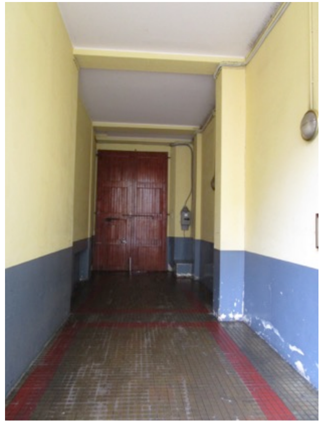
5. Accesso carraio da Via Pulci, vista dal cortile condominiale.
