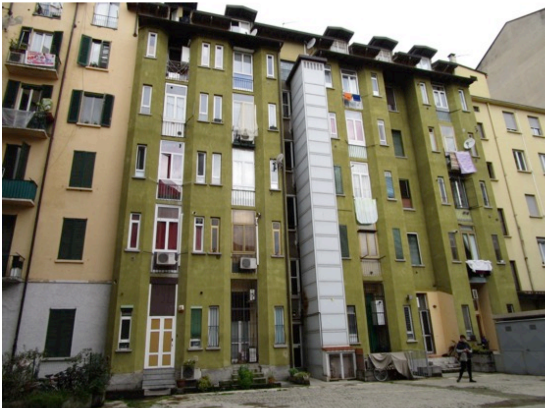
3. Fabbricato vista dal cortile interno.
