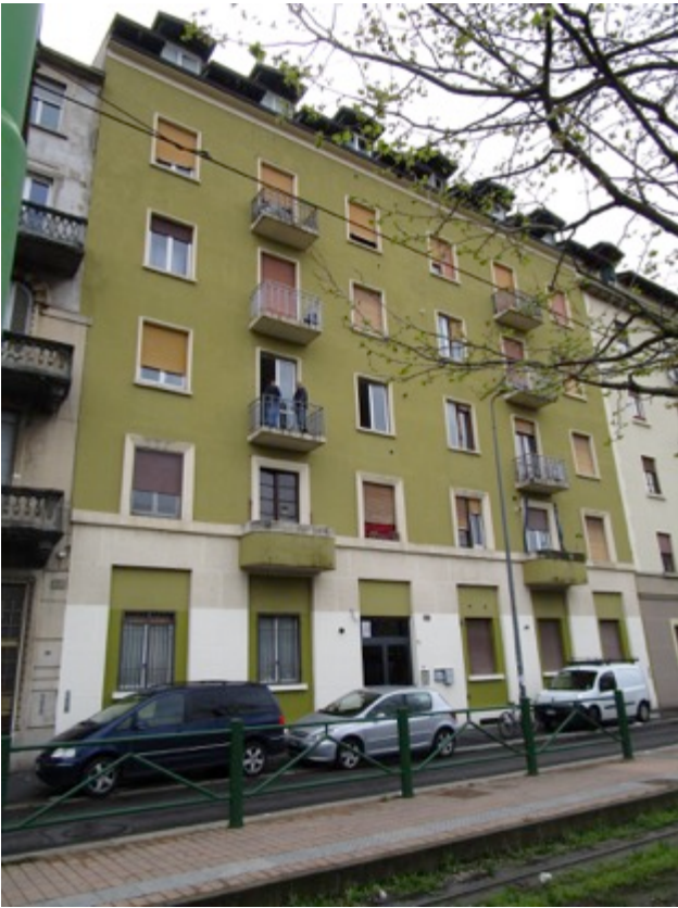
1. Fabbricato di Viale Fulvio Testi 182.
