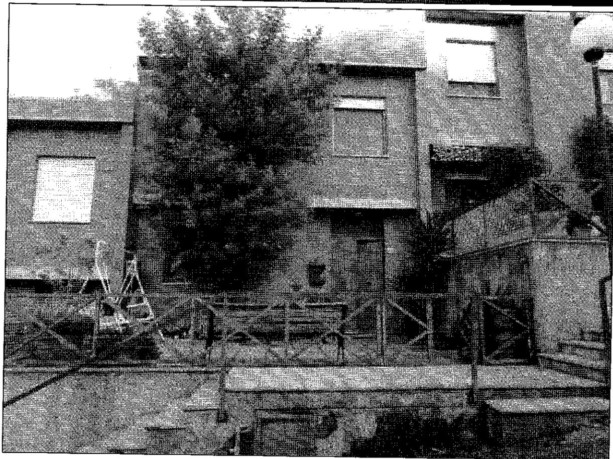
Documentazione fotografica – Esterni lato ovest
