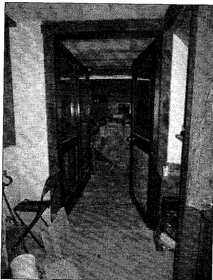
Documentazione fotografica – Interni piano terra e seminterrato
