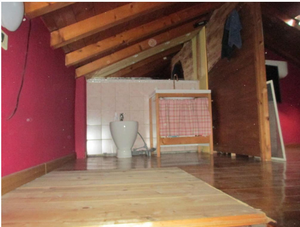
Foto 10: locale sottotetto abusivo
