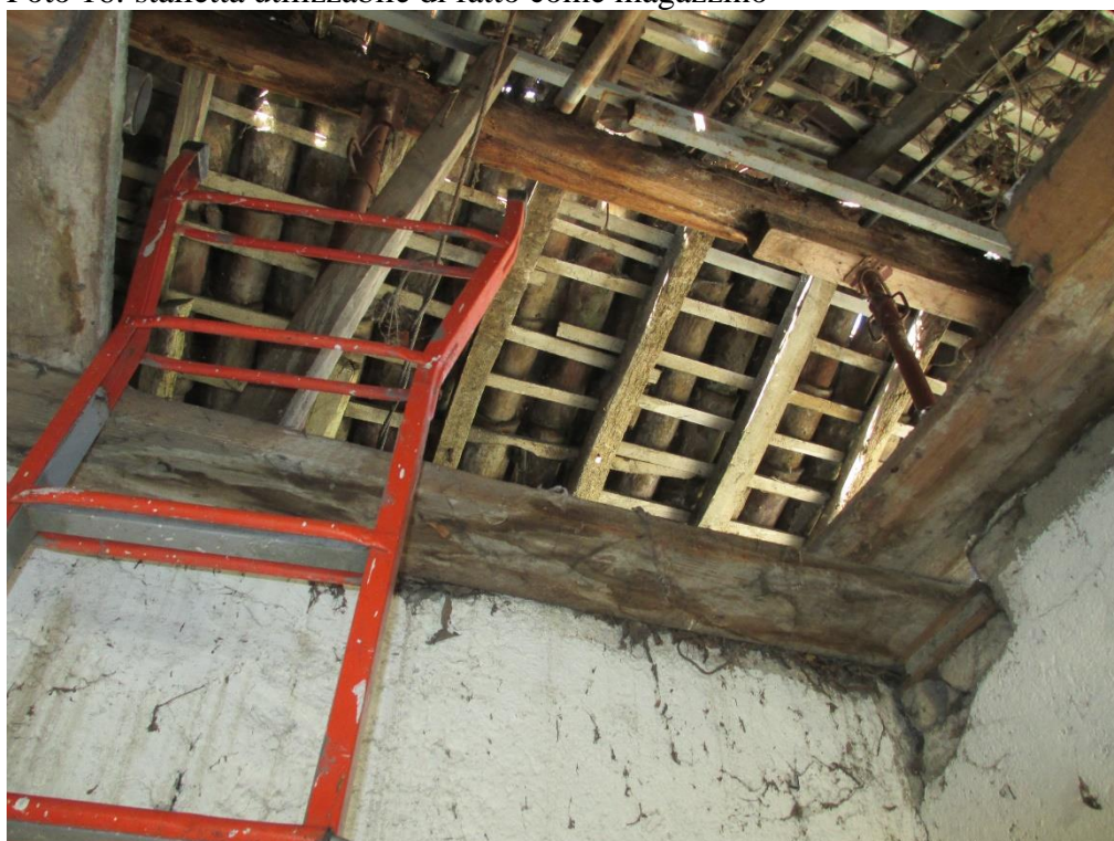
Foto 17: stalletta primo piano – tetto puntellato
