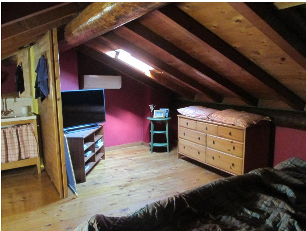
Foto 12: locale sottotetto abusivo
