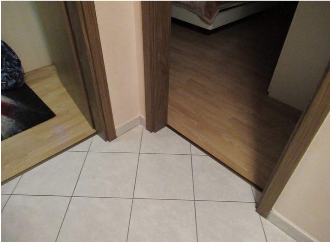
Foto 13: Particolare pavimento camere
