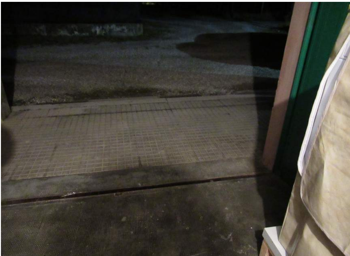
Foto 16: Accesso posto auto coperto sub 7
