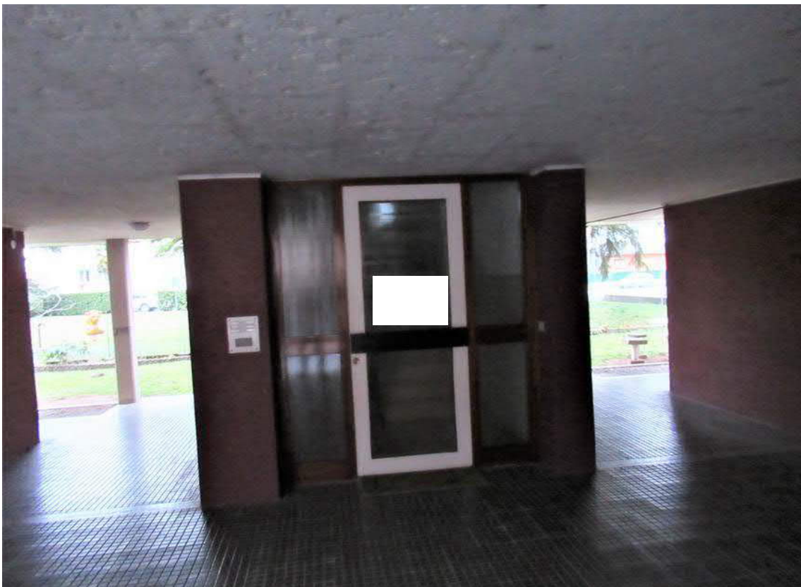
Foto 6: Ingresso agli appartamenti
