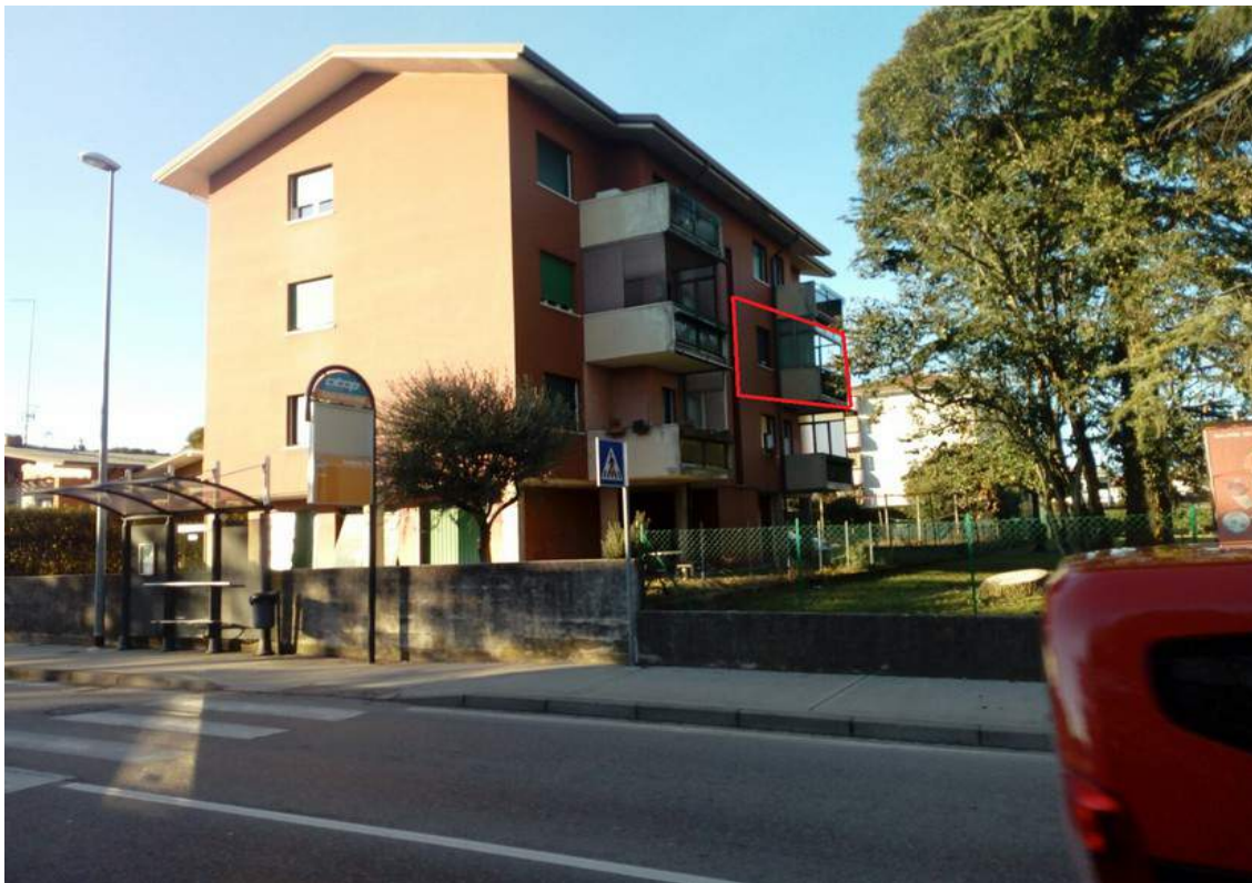
Foto 1: Alloggi visti da Sud-Est
