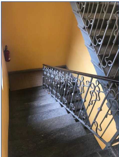
Foto 9 - vano scala comune
