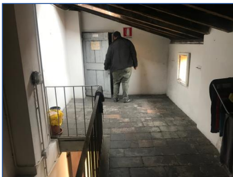
Foto 27 - spazi comuni piano sottotetto
