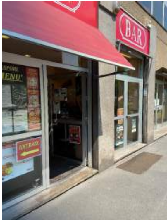
Vista ingresso sulla via Restelli
