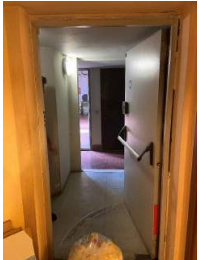
vista verso il cavedio lato sinistro
