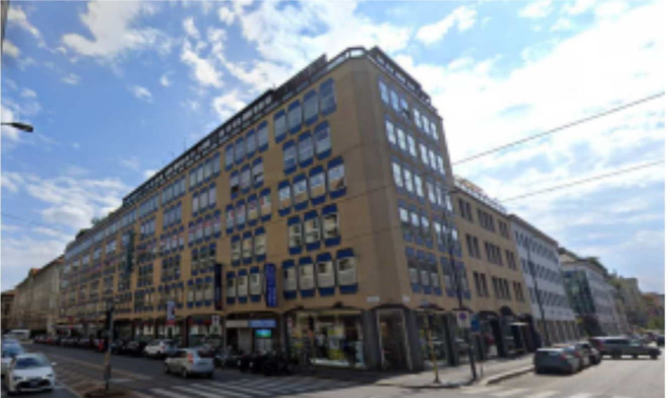
Foto n. 1 – Prospetto dell’edificio di via Vitruvio 43
