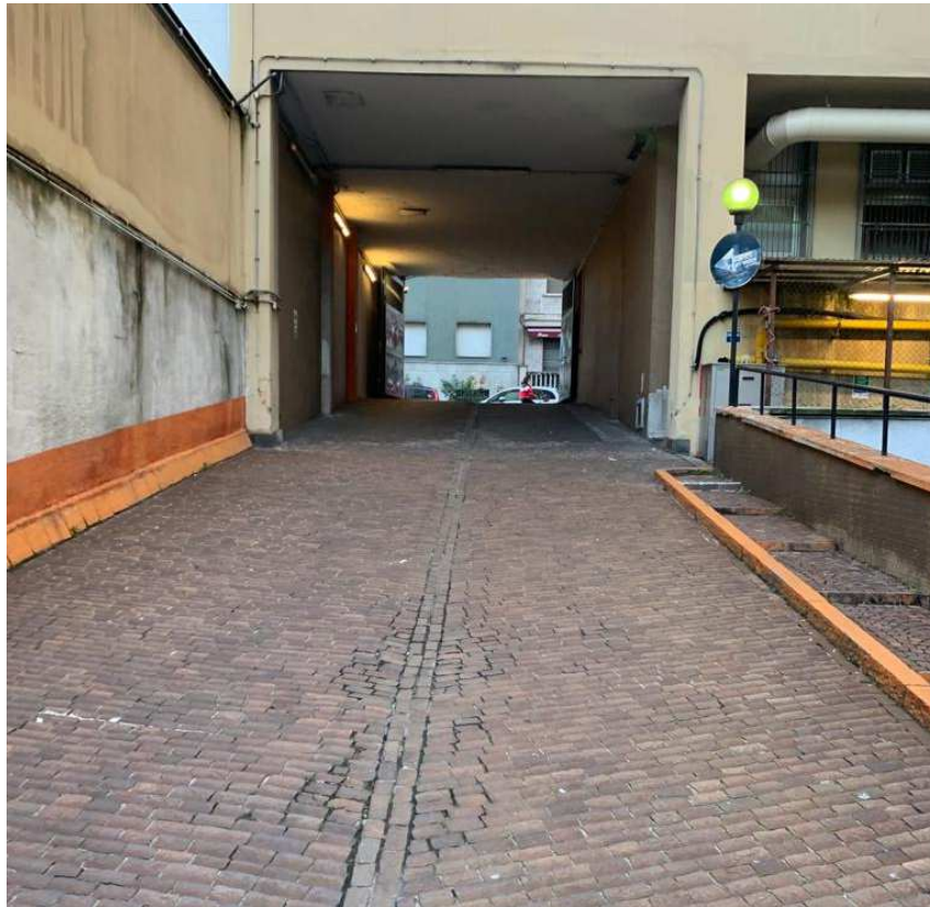
Foto n. 3 – Rampa di accesso al corsello
