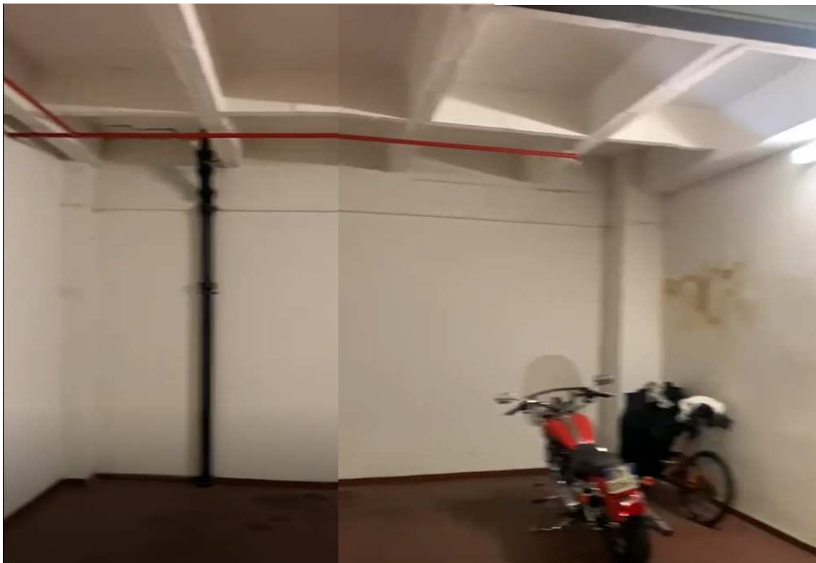
Foto n. 9 – Altra Veduta interna Autorimessa
