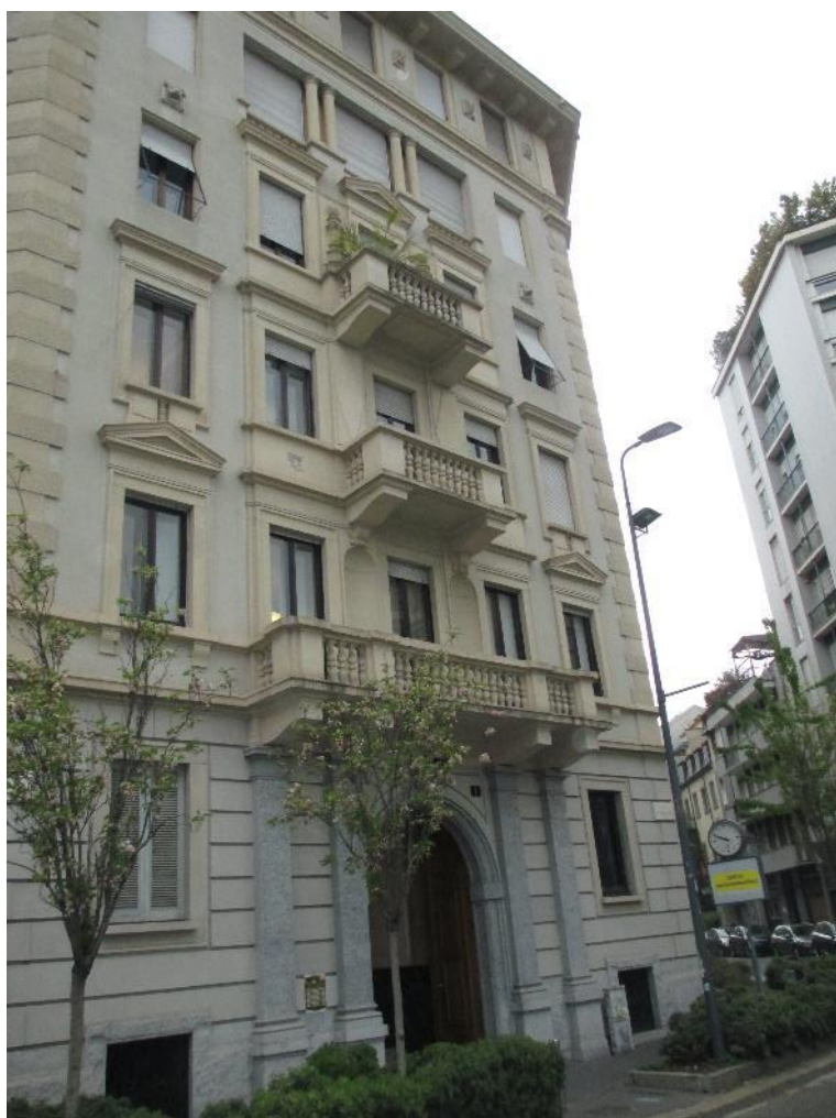
Foto 1: esterno condominio piazza de' Lellis 1 Milano
