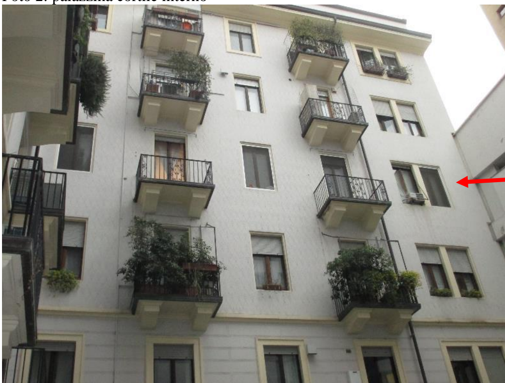
Foto 3: individuazione appartamento in facciata
