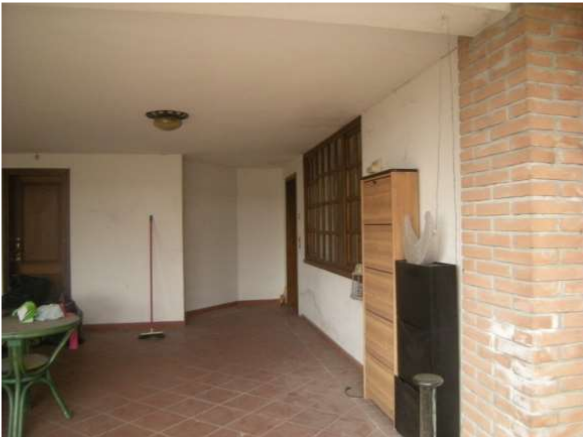
San Vito al Tagliamento, via Oberdan n. 84, piano terra – Il posto auto.
