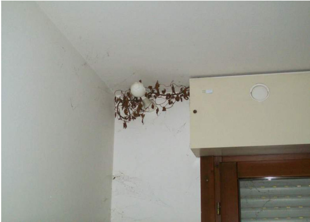
Foto 45a.3: particolare cassonetto porta-finestra soggiorno
