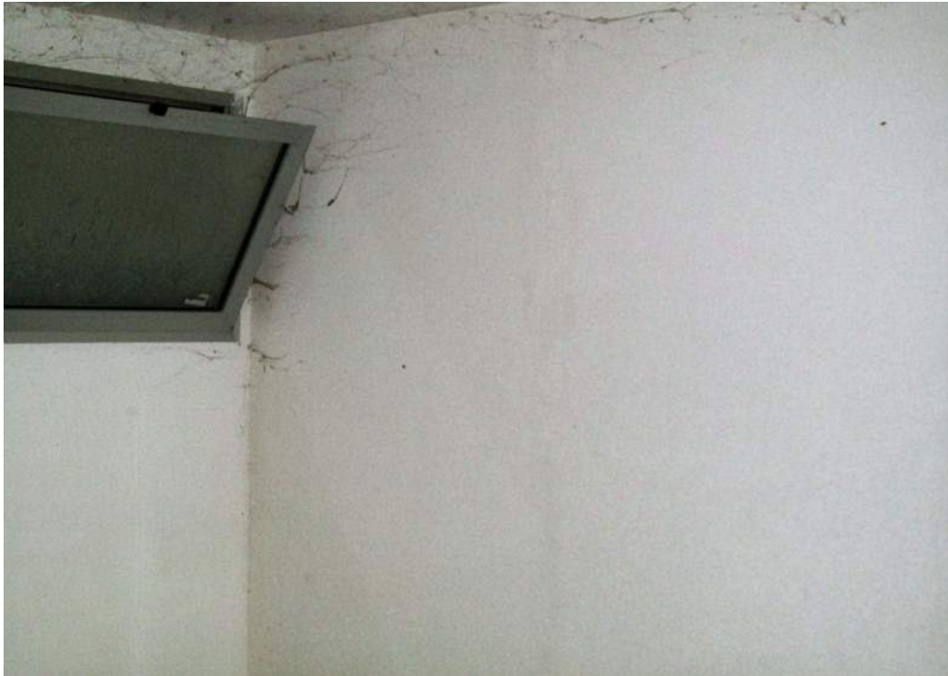
Foto 45a.9: interno garage piano interrato, parete Ovest
