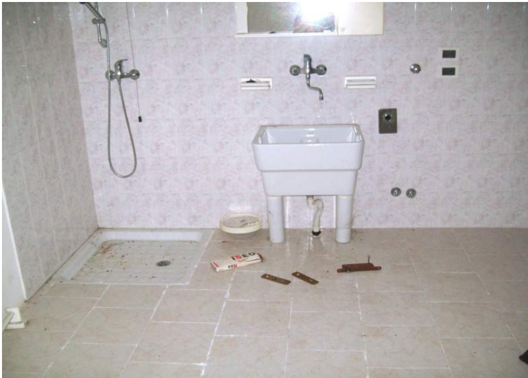
Foto 45a.8: interno lavanderia piano interrato
