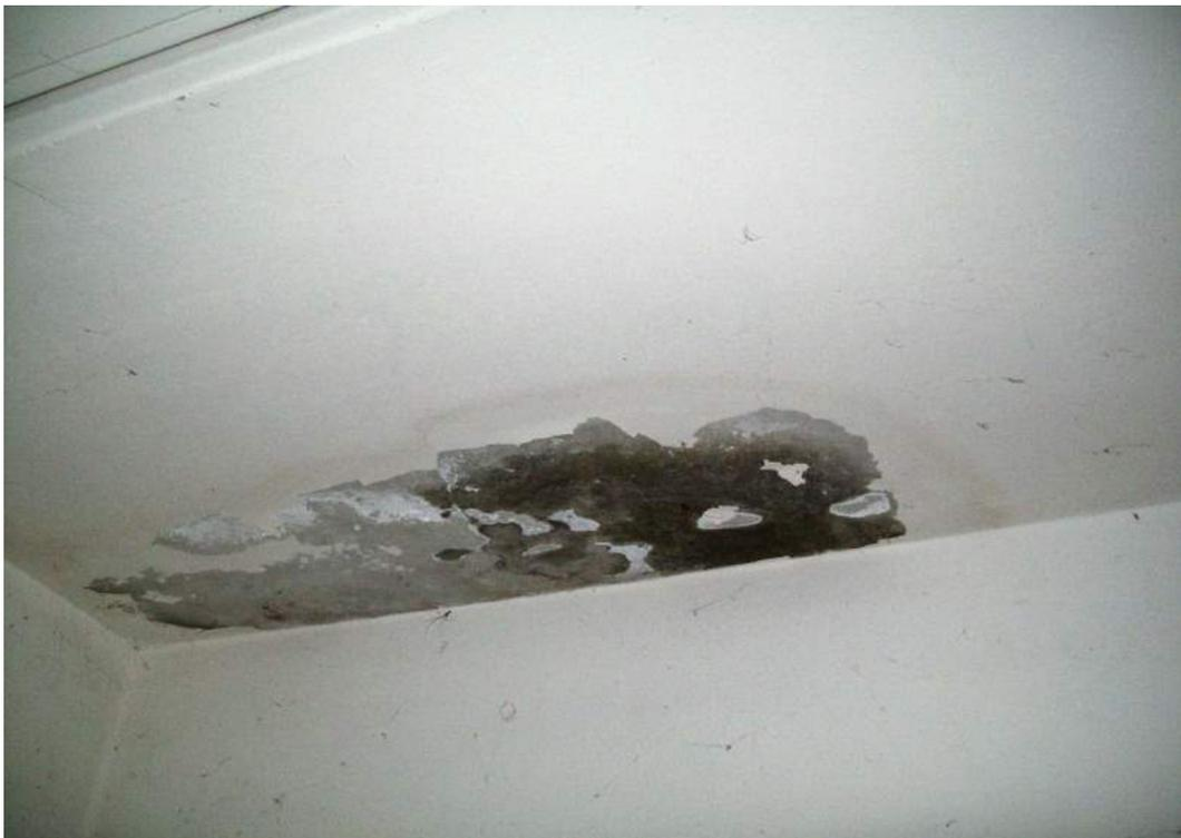
**Foto 43d.11:** infiltrazione soffitto garage
