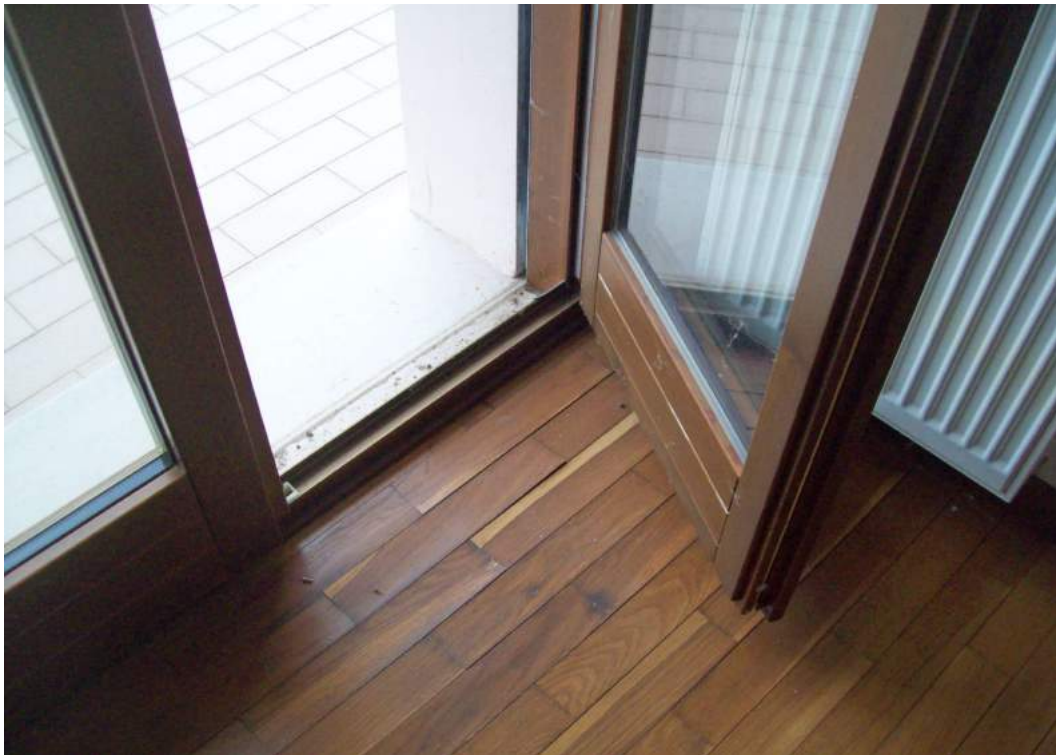
Foto 43c.6: particolare pavimento ligneo camera
