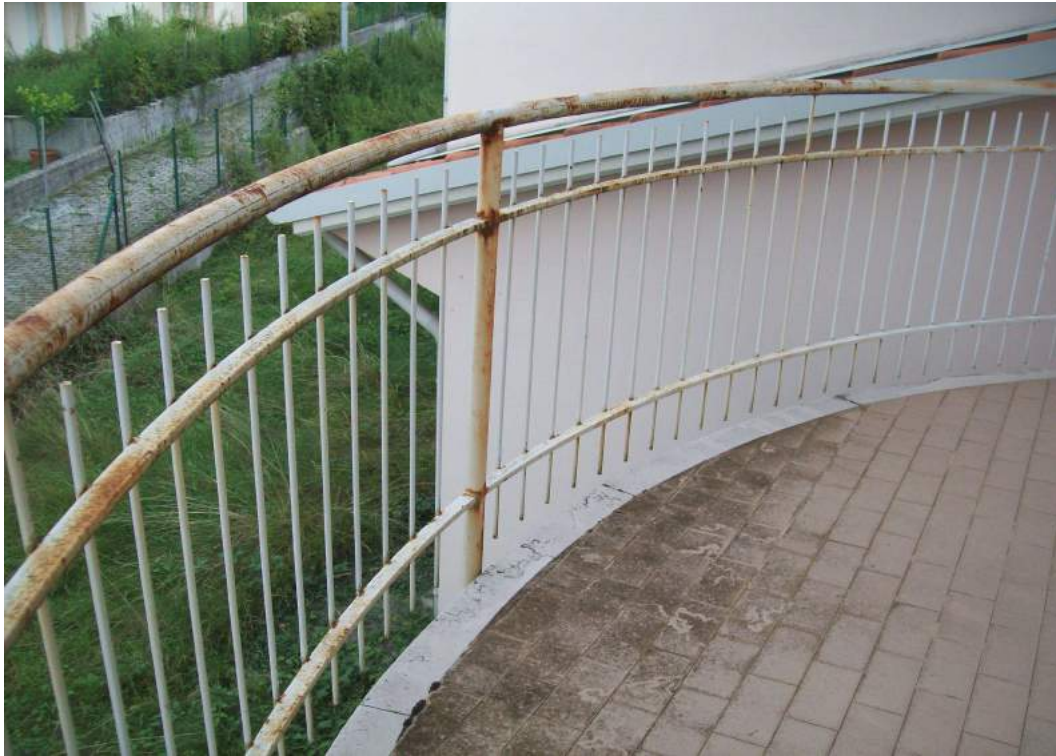
Foto 43c.3: particolare parapetto terrazzo
