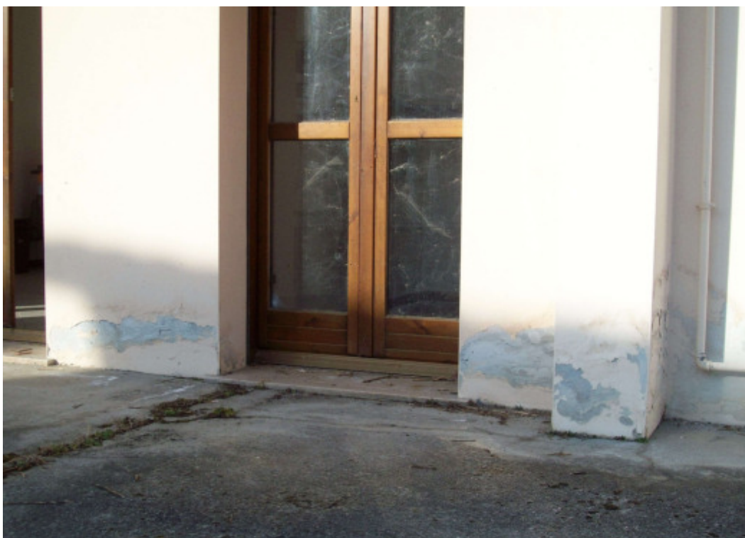
Foto 41b.1: particolare pareti esterne piano terra
