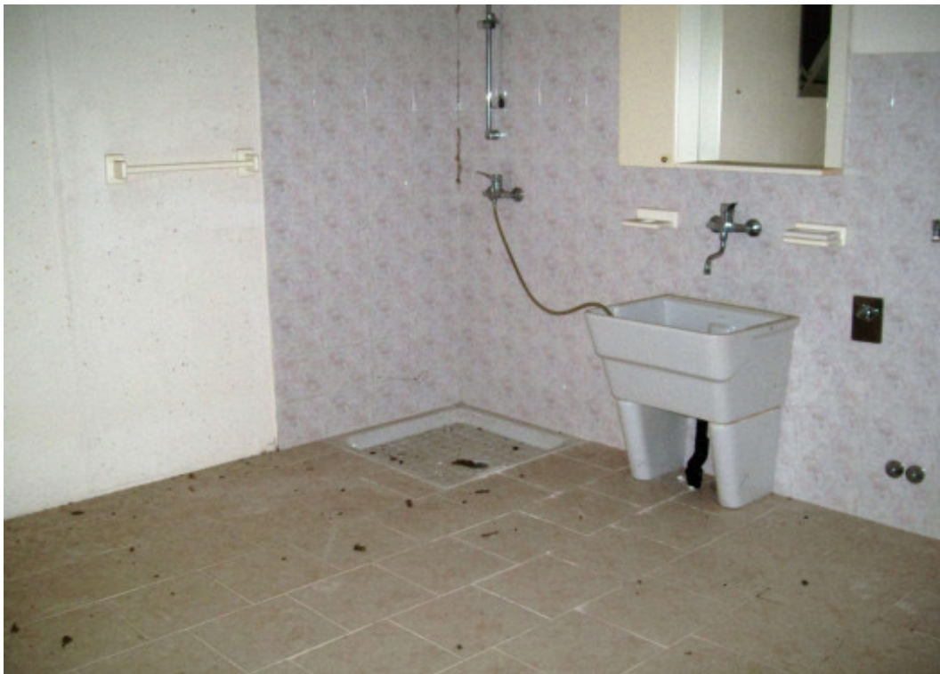
Foto 41b.8: interno lavanderia piano interrato
