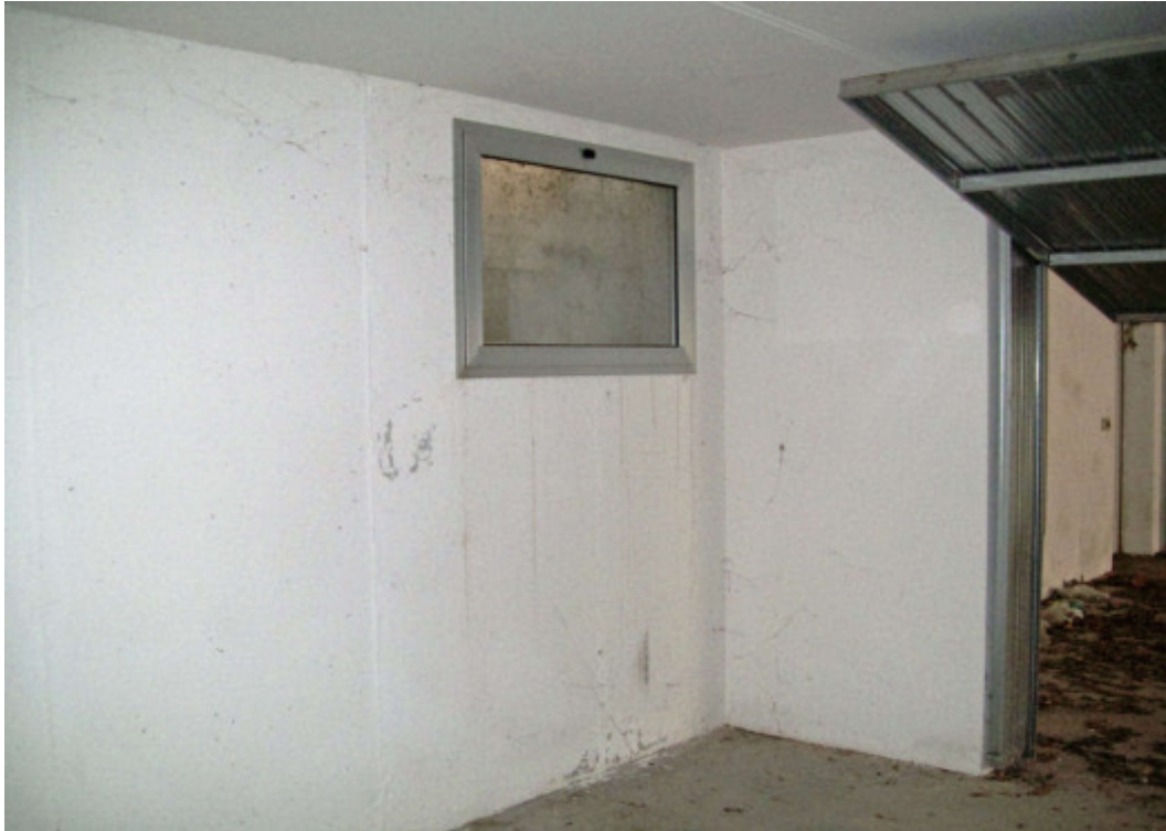
Foto 41b.9: interno garage piano interrato
