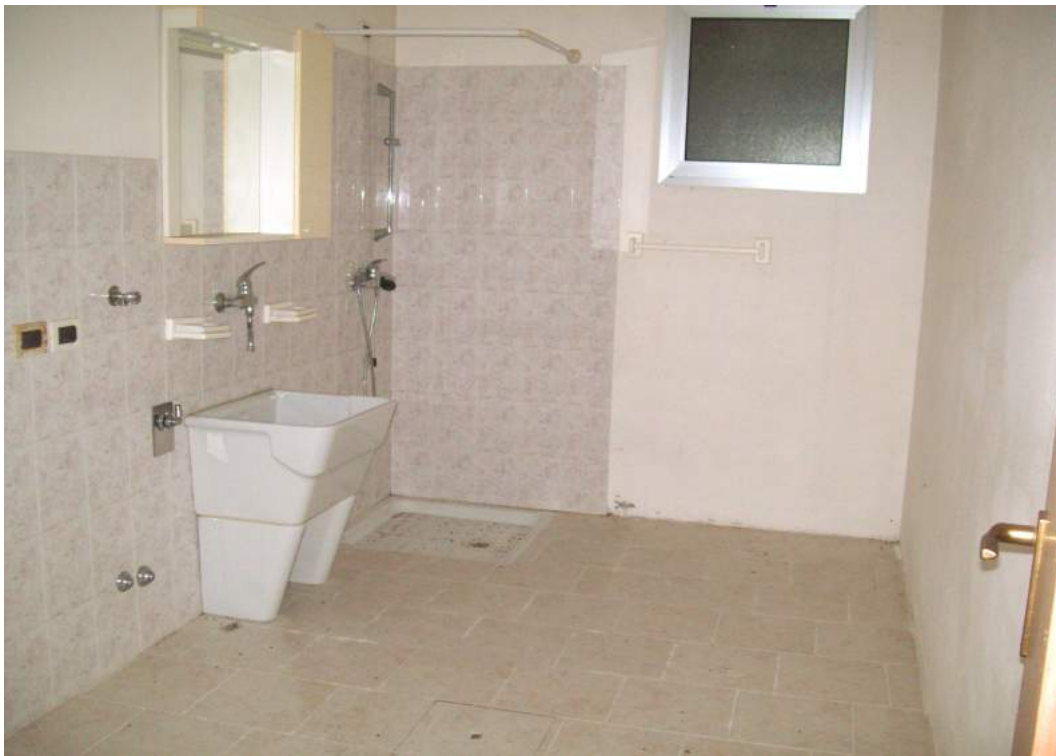
Foto 43a.10: interno lavanderia piano interrato
