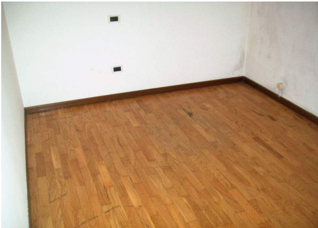
Foto 43a.6: interno camera
