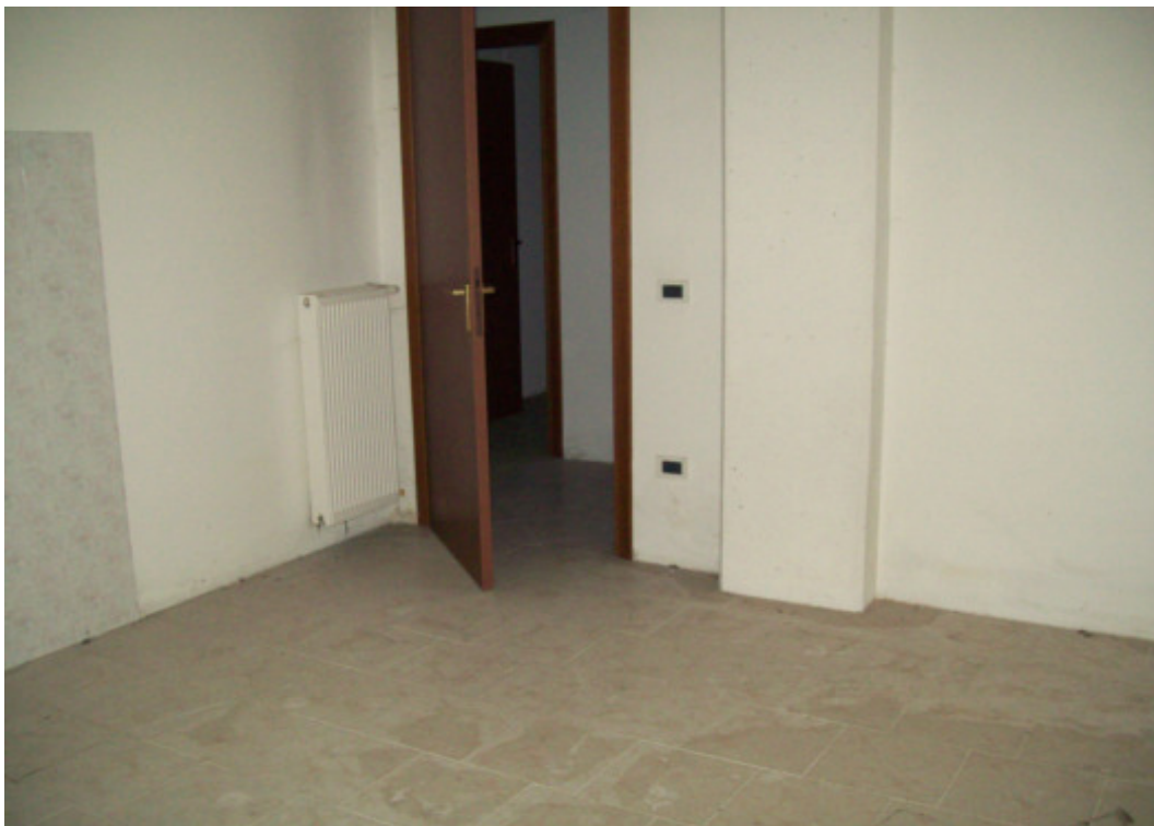
Foto 41a.8: ingresso lavanderia piano interrato
