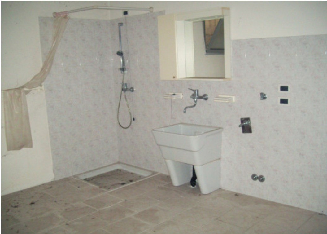
Foto 41a.9: interno lavanderia piano interrato
