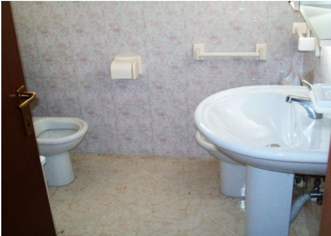
Foto 41a.4: bagno principale
