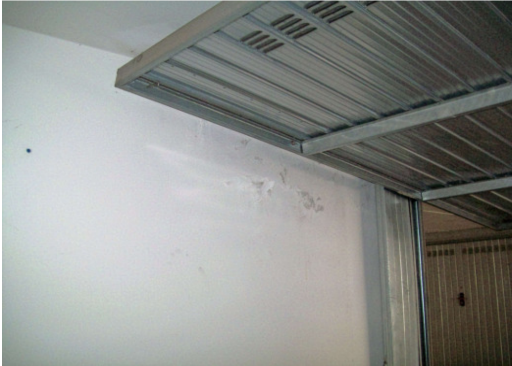
Foto 41a.11: infiltrazione parete divisoria garage
