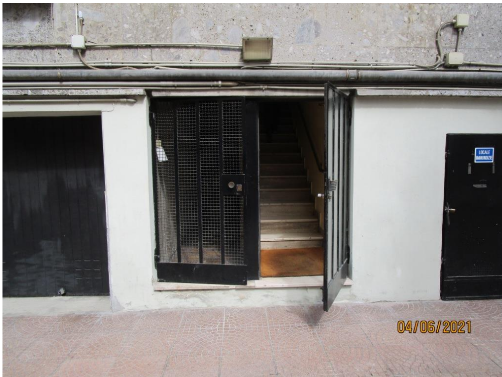
Foto 21 – Parti comuni: scale di accesso al piano cantinato
