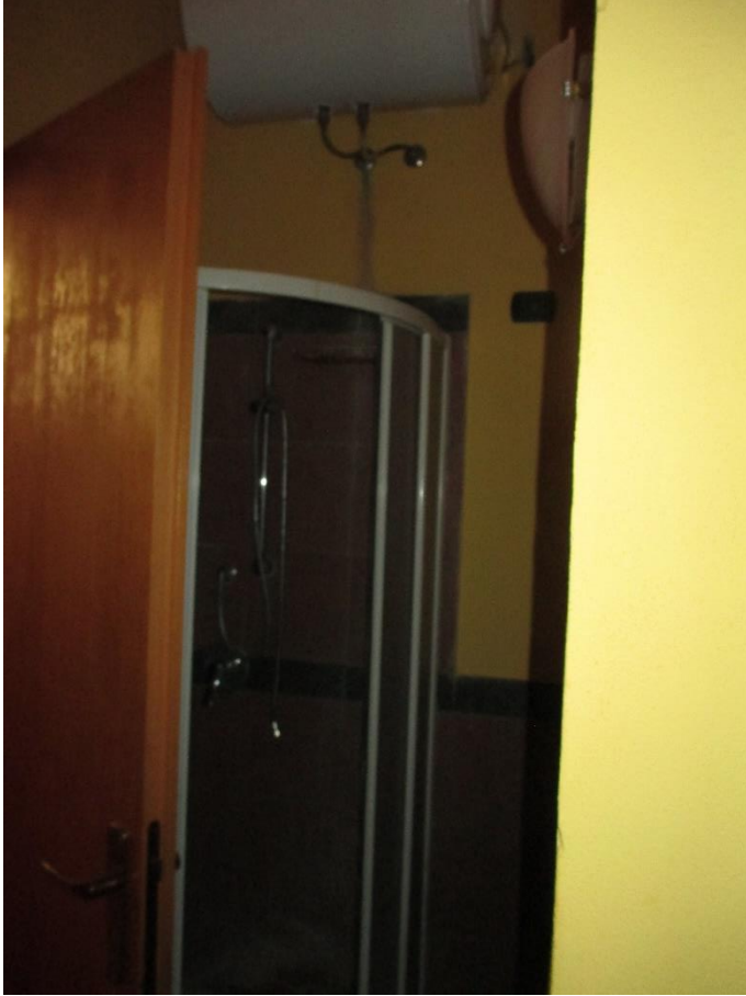
Foto 16: box doccia bagno ufficio 3
