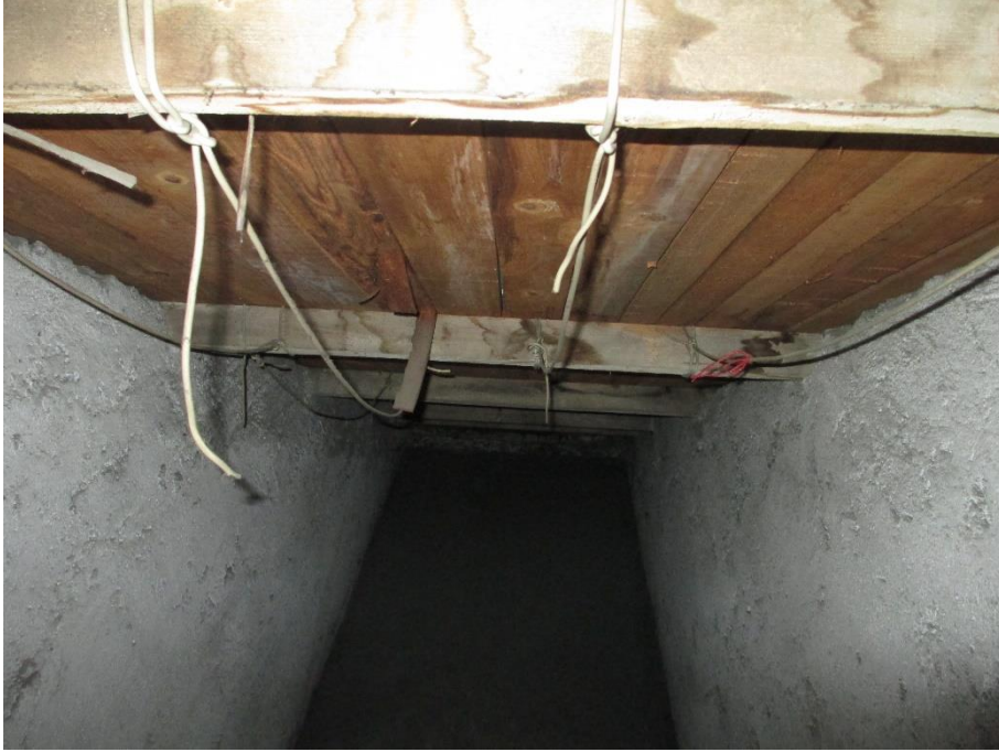
Foto 24: solaio in fondo
