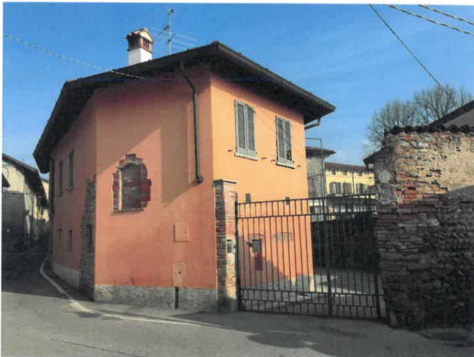
Foto n.2 – Prospetto su via Magenta – civico 11
