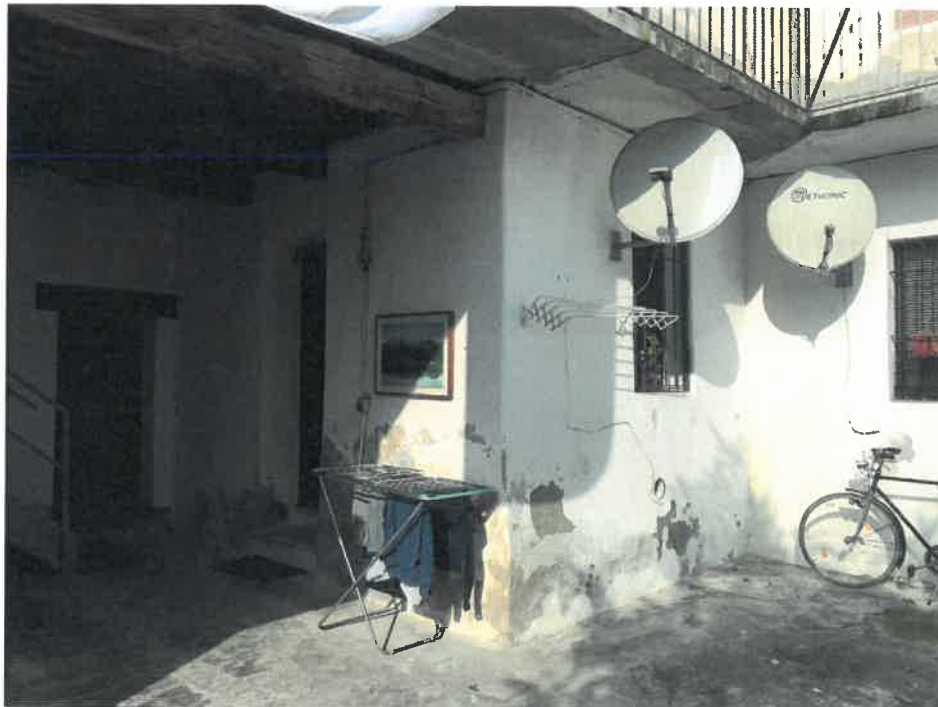
Foto n.4 – unità immobiliare in esame – porta di ingresso
