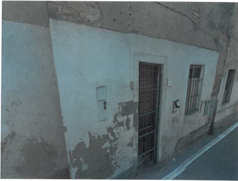
Foto n.1 – Prospetto su via Magenta – civico 9
