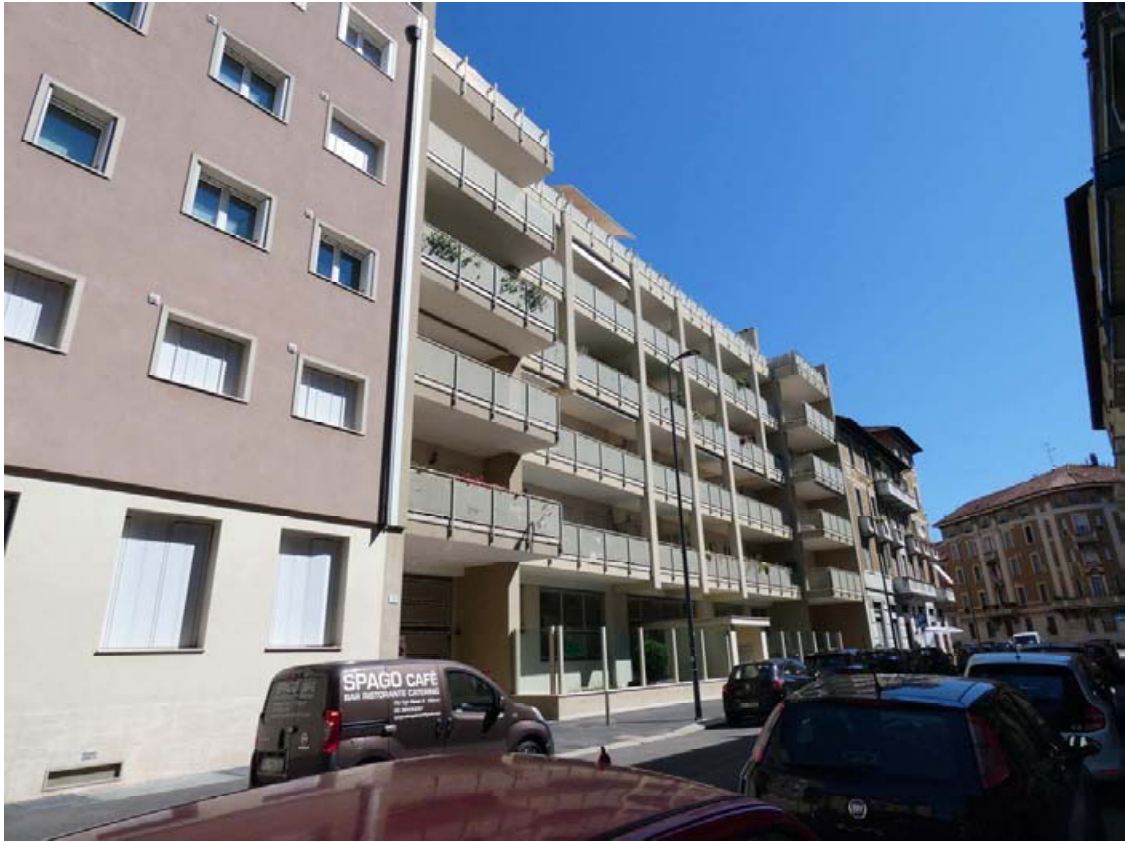
Foto 1. Prospetto su Via Giulio Belinzaghi
