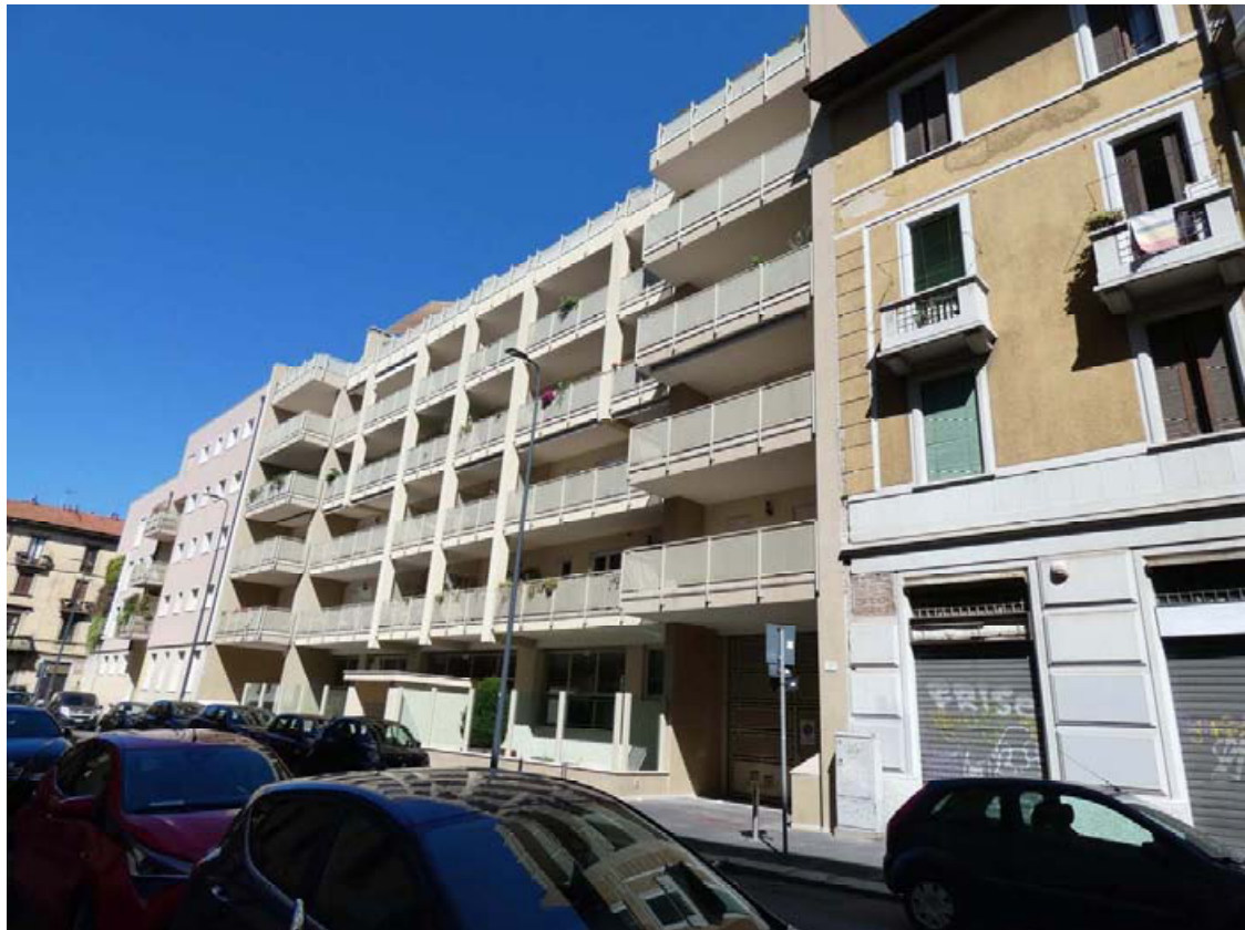
Foto 2. Prospetto su Via Giulio Belinzaghi
