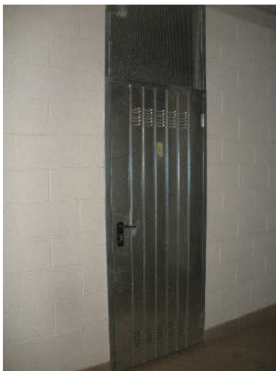
Fotografia 06 – Porta accesso locale Cantina sub. 41 (Non è stata possibile la visione interna)
