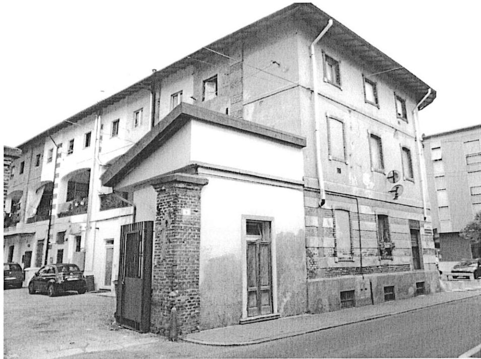
PROSPETTO FABBRICATO (con fronte su Via Cesare Battisti)
