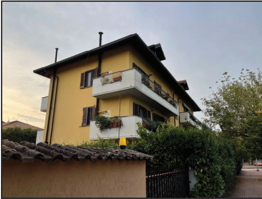
Vista da via U. Foscolo lato SUD
