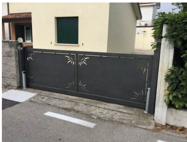
vista esterna del cancello scorrevole nell' l'accesso carraio
