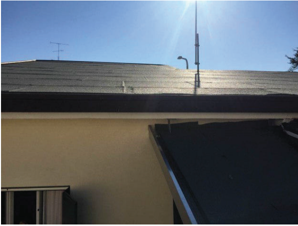
particolare vista esterna della copertura con guaina in cartone catramato
