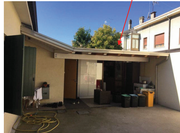
vista esterna del porticato e ripostiglio abusivo sul lato Nord del fabbricato
