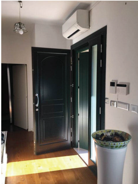
particolare della porta d'ingresso principale
