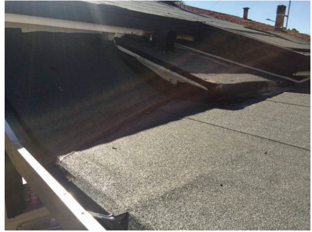
ulteriore vista esterna della copertura con guaina in cartone catramato
