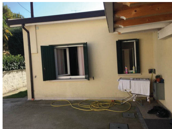
particolare di una parte del prospetto lato Nord
