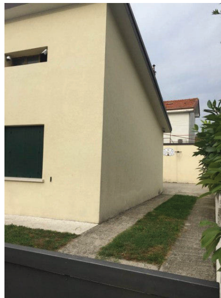
particolare prospetto lato Est
