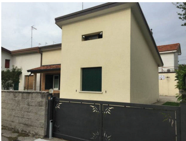
particolare prospetto lato Sud-Est
