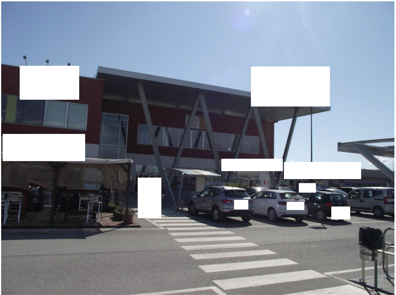
Foto 3 vista frontale stabile
