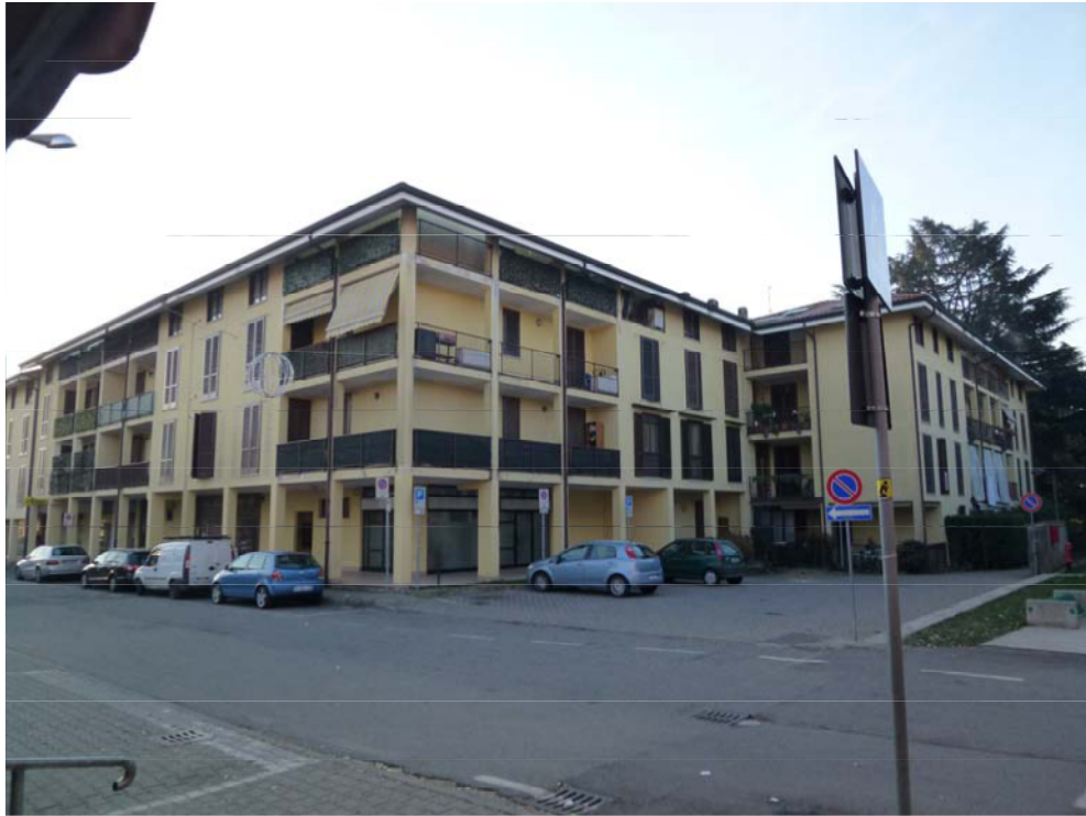
Foto 1 – Fabbricato vista esterna
