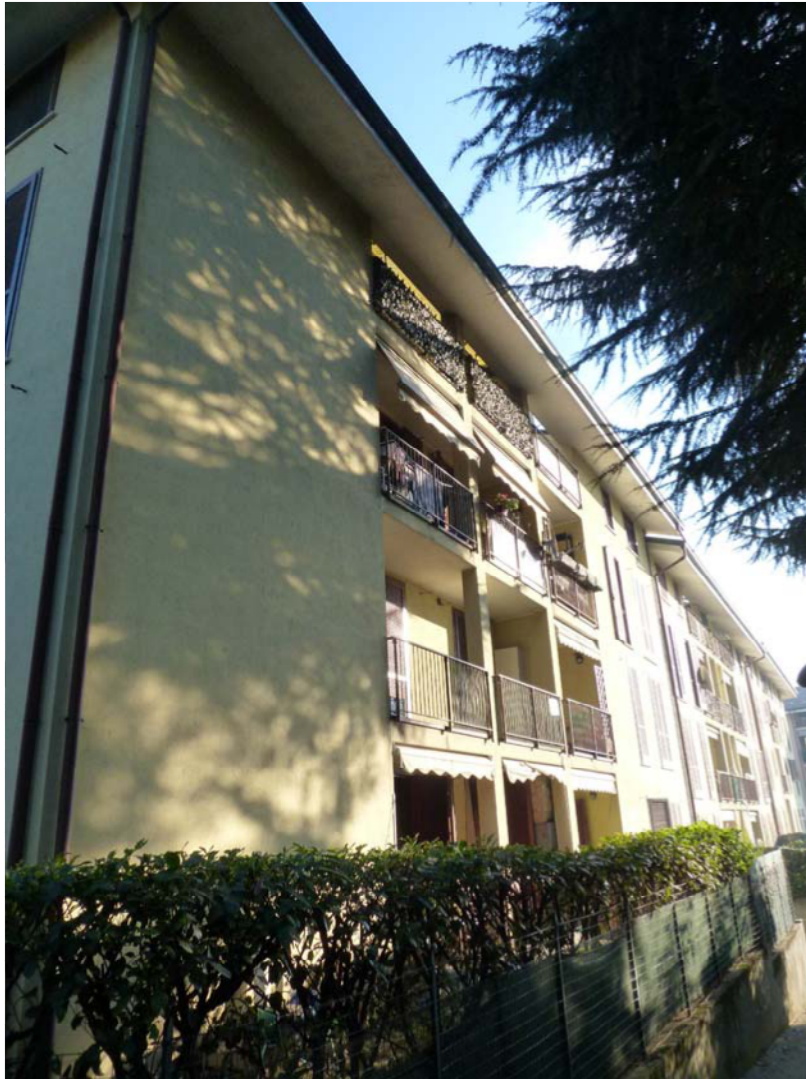
Foto 3 – Edificio, vista da giardino
