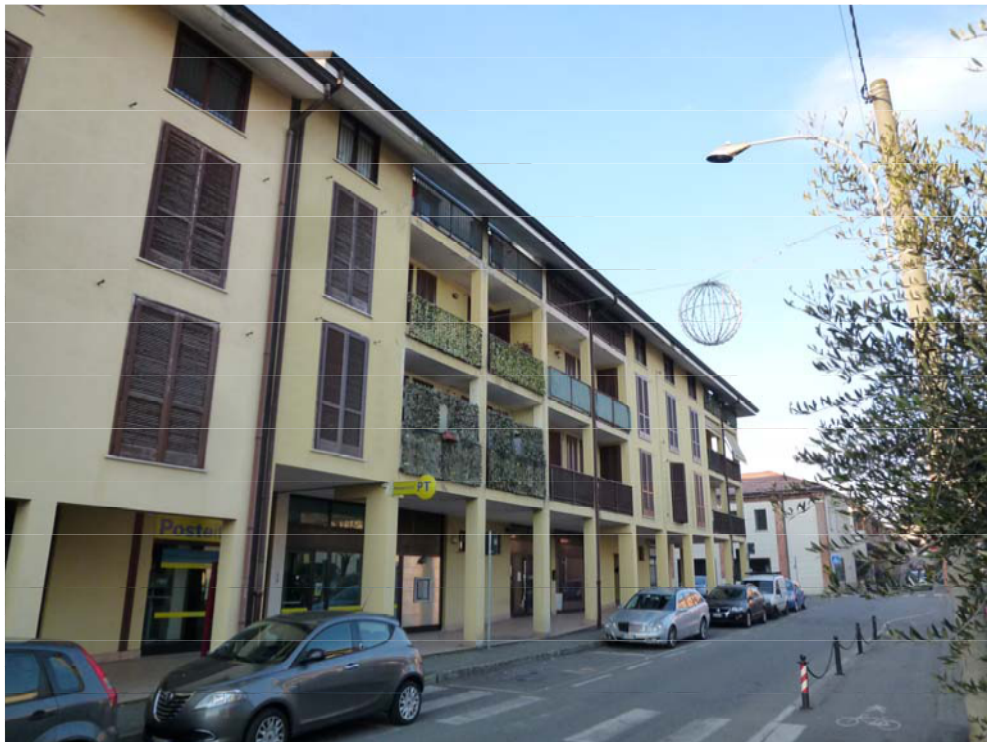
Foto 2 – Edificio vista via Cavour
