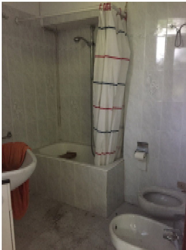
Foto 15 - Bagno al piano terra
