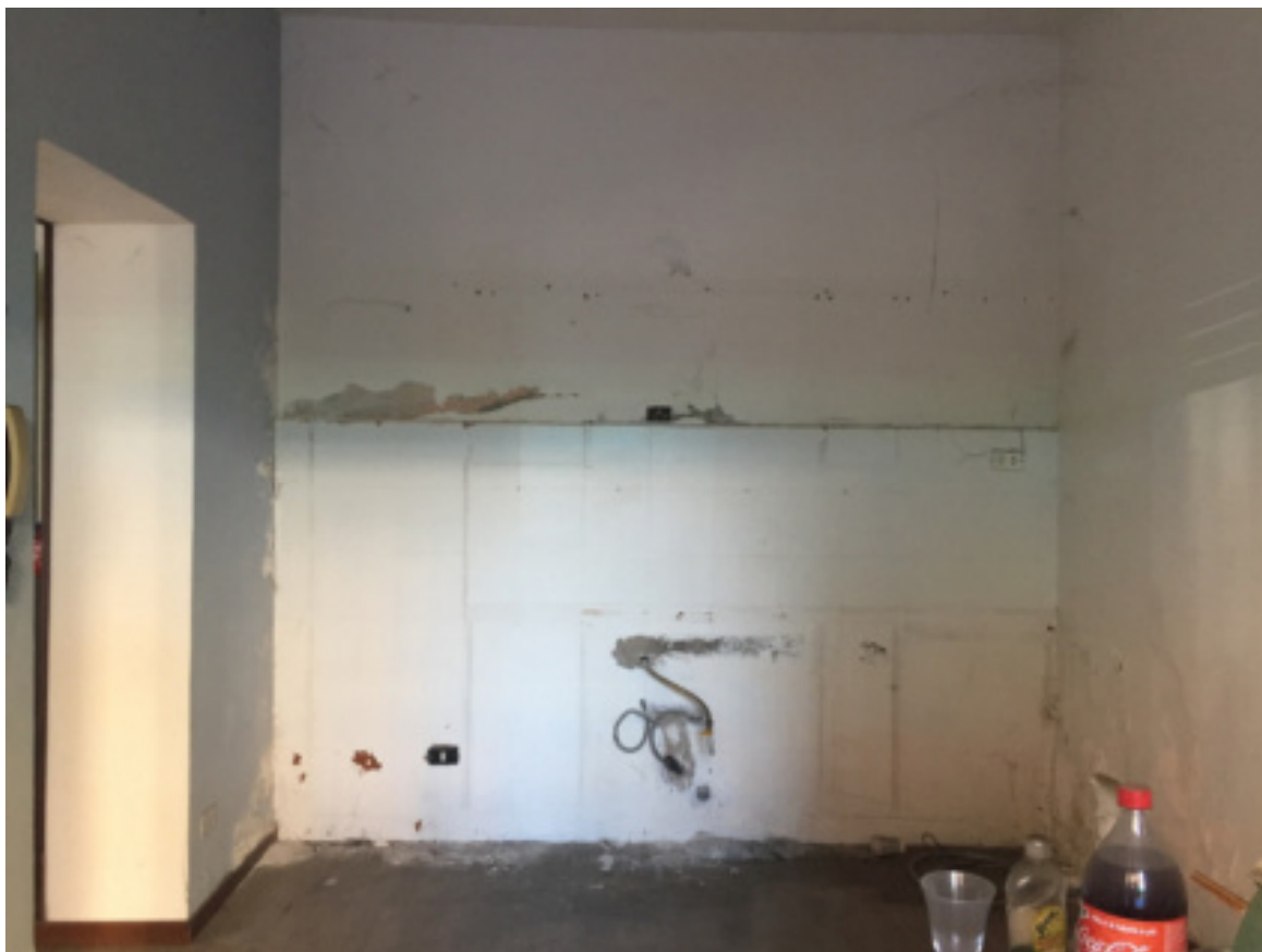
Foto 11 - Cucina al piano terra
