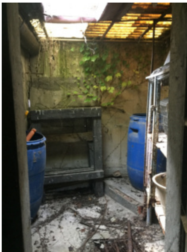
Foto 36 - Tettoia al piano terra
