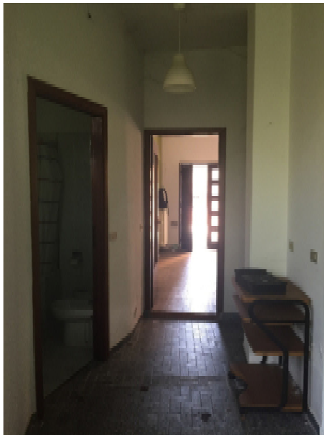
Foto 14 - Disimpegno al piano terra
