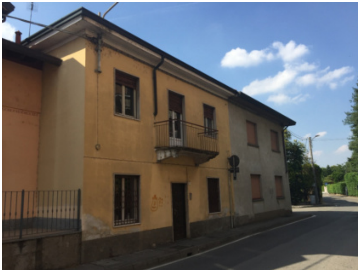
Foto 01 - Il fabbricato su via Trento al civico 7
