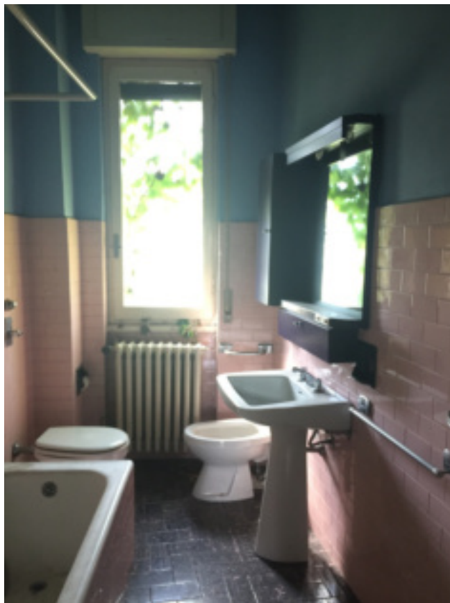
Foto 27 - Bagno al primo piano
