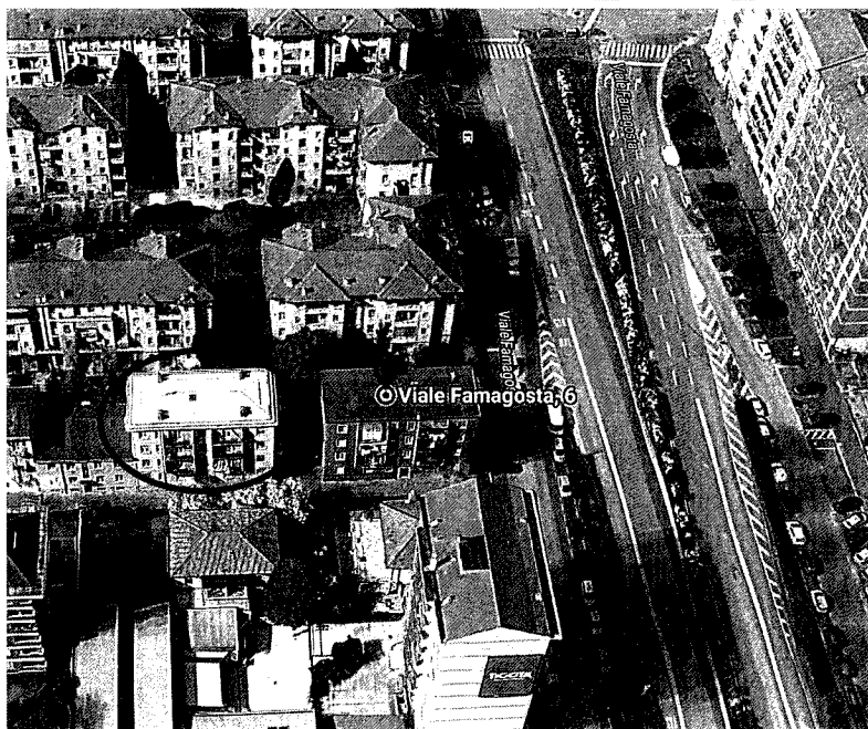
Fig. 1 - 2: inquadramento territoriale - vista aerea del fabbricato
