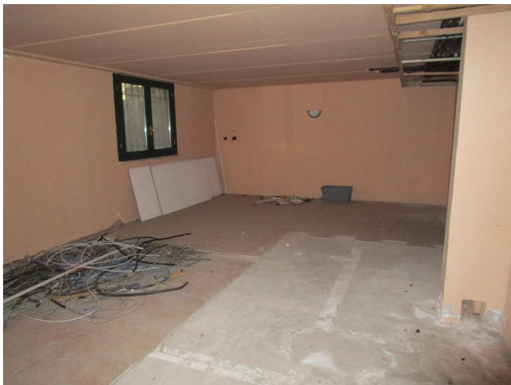
Foto 68 – Piano terra (area in fase di ricostruzione)
