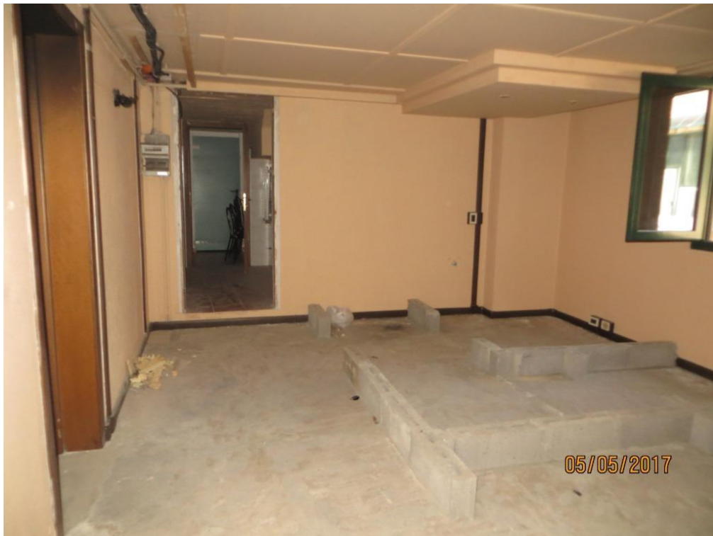
Foto 66 – piano terra dell'albergo (area in fase di ricostruzione)
