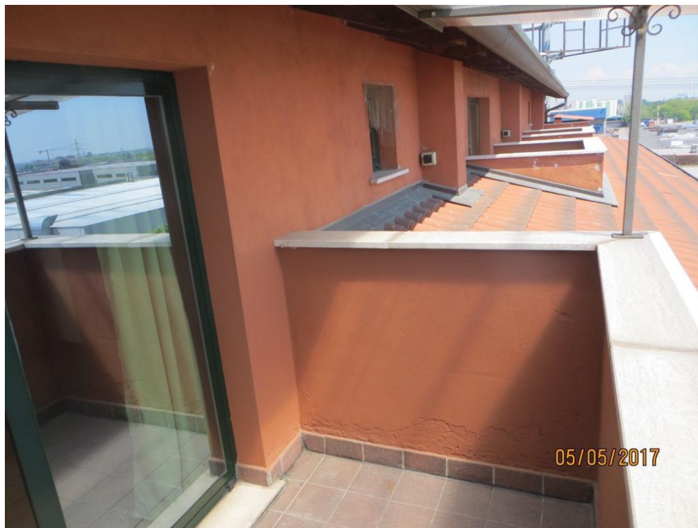
Foto 86 – Balcone a servizio della camera singola al piano terzo
