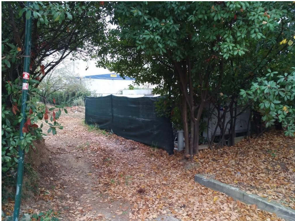
Foto 97 – Area scoperta posta a confine dell'area di proprietà comunale. Sono presenti impianti attualmente in disuso
