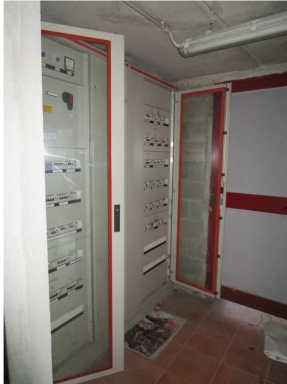
Foto 65 – Vano tecnico al piano terra
