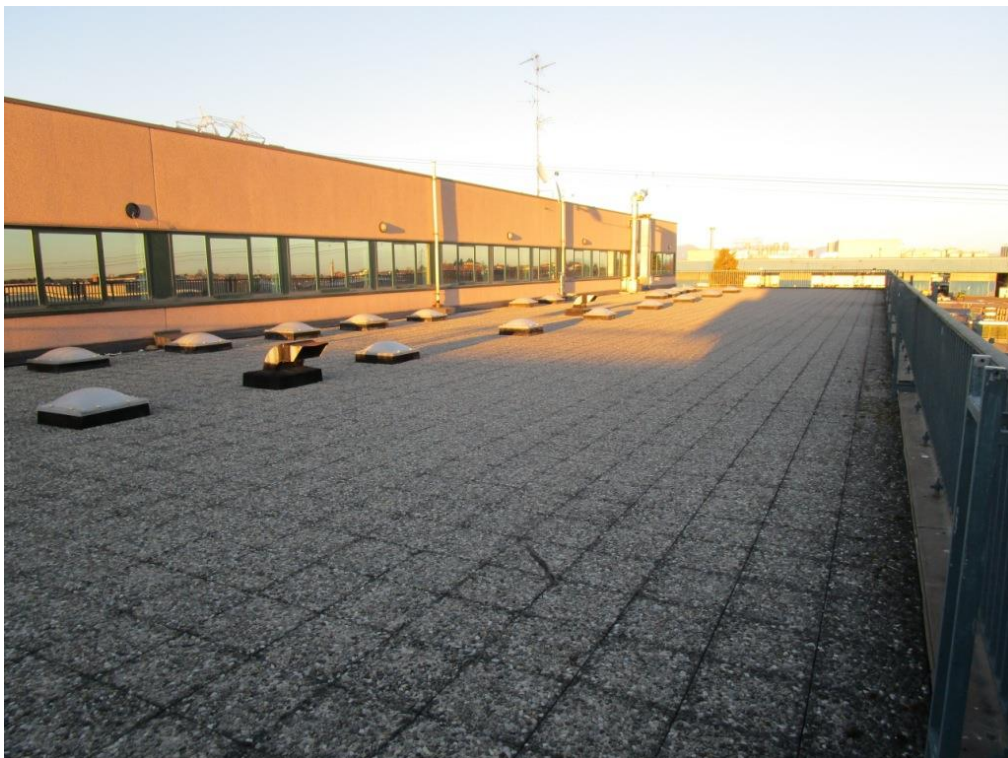
Foto 24 – Copertura al piano primo
