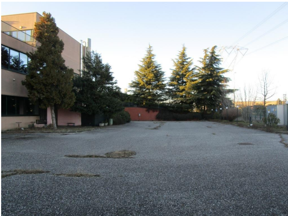
Foto 4 – Vista dell'area (corpo di fabbrica D) di proprietà comunale
