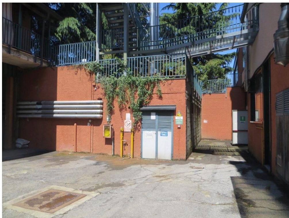
Foto 40 – Vista dal cortile interno della centrale termica (attualmente in disuso)
