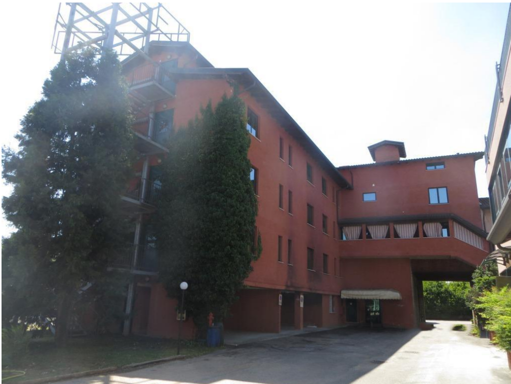
Foto 62 – Vista dell'albergo dal cortile comune
