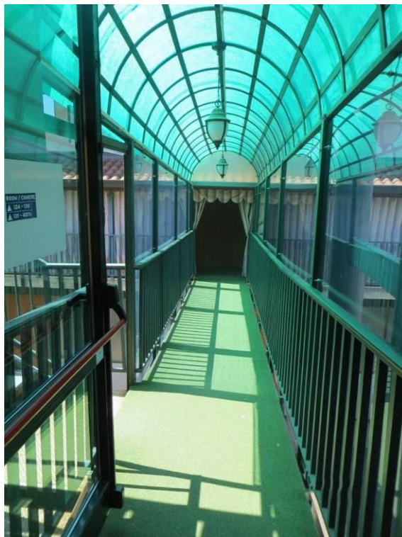
Foto 30 – Vista del passaggio coperto di collegamento tra le due strutture alberghiere
