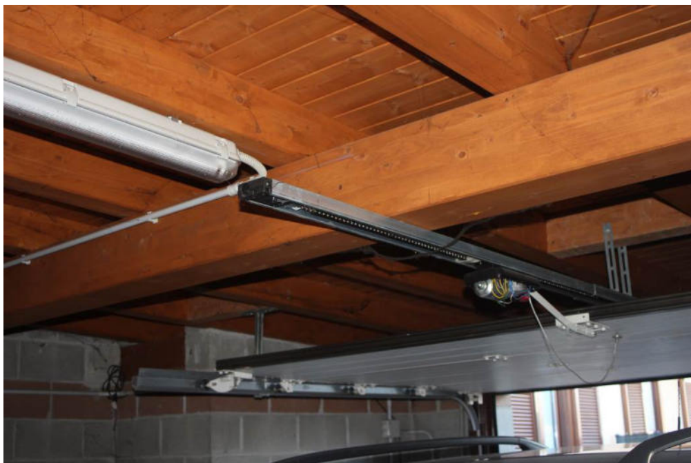
FOTO 16: MARCALLO CON CASONE, VIA BECCARIA 12-18, interno box
