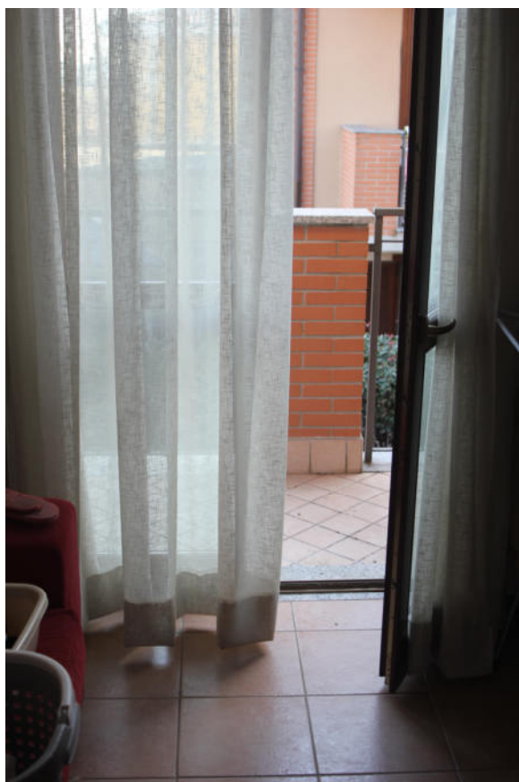
FOTO 8: MARCALLO CON CASONE, VIA BECCARIA 12-18, balcone 1° piano
