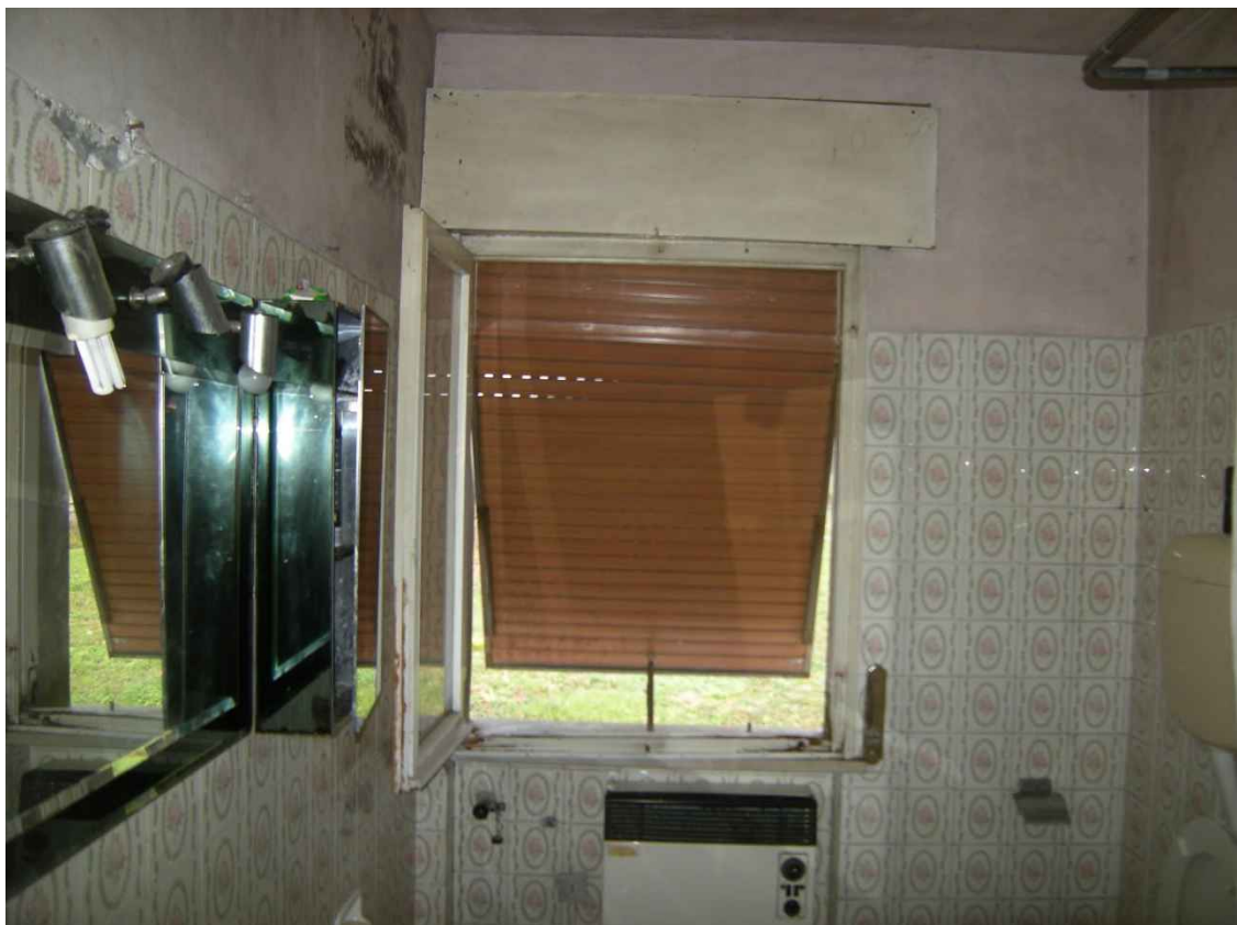
Maron di Brugnera, via I Maggio s.n° - Particolari degli infissi esterni.
