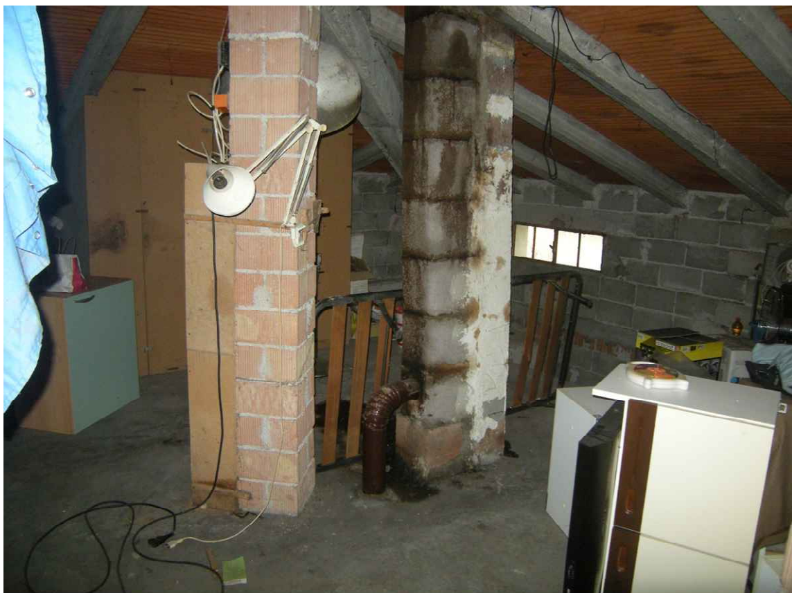
Maron di Brugnera, via I Maggio s.n° - La soffitta.
