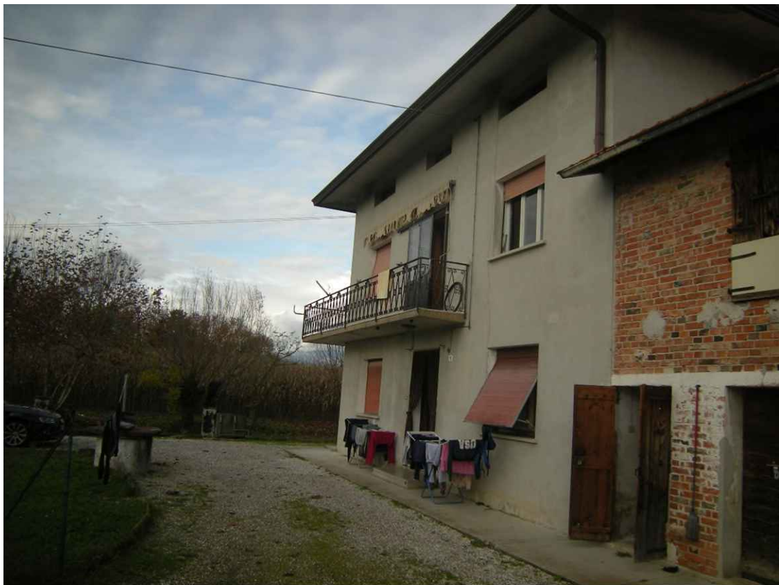
Maron di Brugnera, via I Maggio s.n° - Il fabbricato 1 adibito a cantina e fienile.
