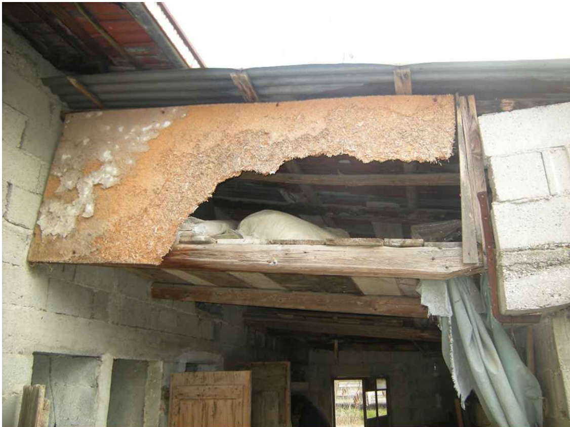
Maron di Brugnera, via I Maggio s.n° - Il fabbricato 2 adibito a pollaio, legnaia e ricovero attrezzi.
