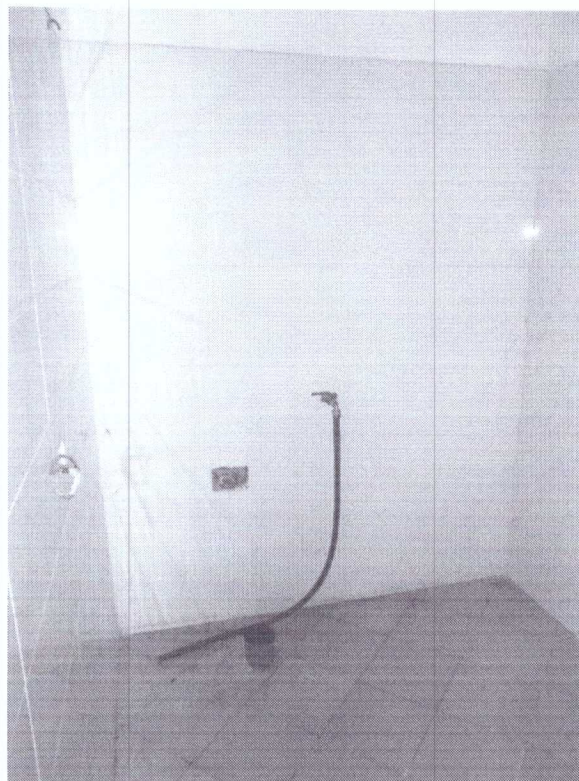
- FOTO 10 - SERVIZIO IGIENICO PER DISABILI -
