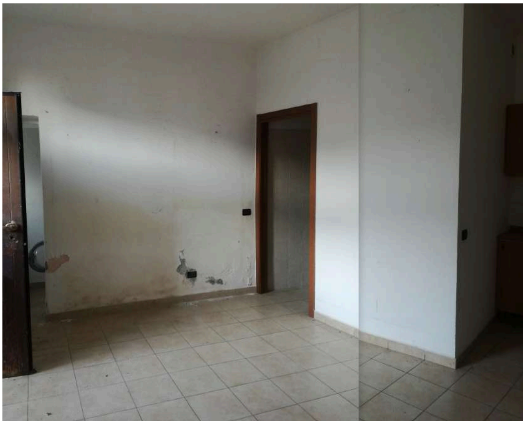
FOTO 7/16 – VISTE INTERNA locale
