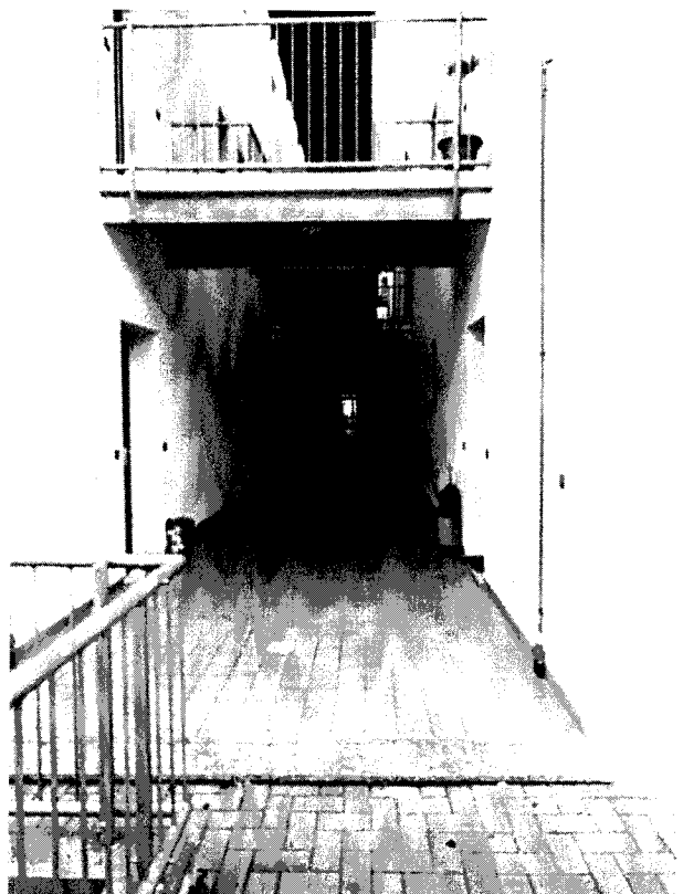
Foto 4: corridoio comune d'accesso al piano terreno
