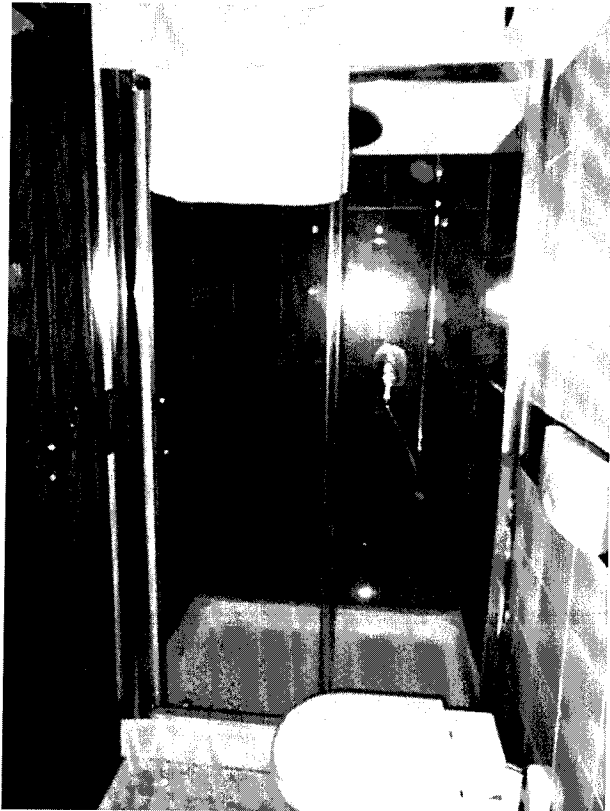
Foto 23: bagno di servizio
