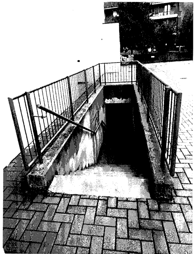
Foto 6: scala d'accesso comune esterna al piano sotterraneo
