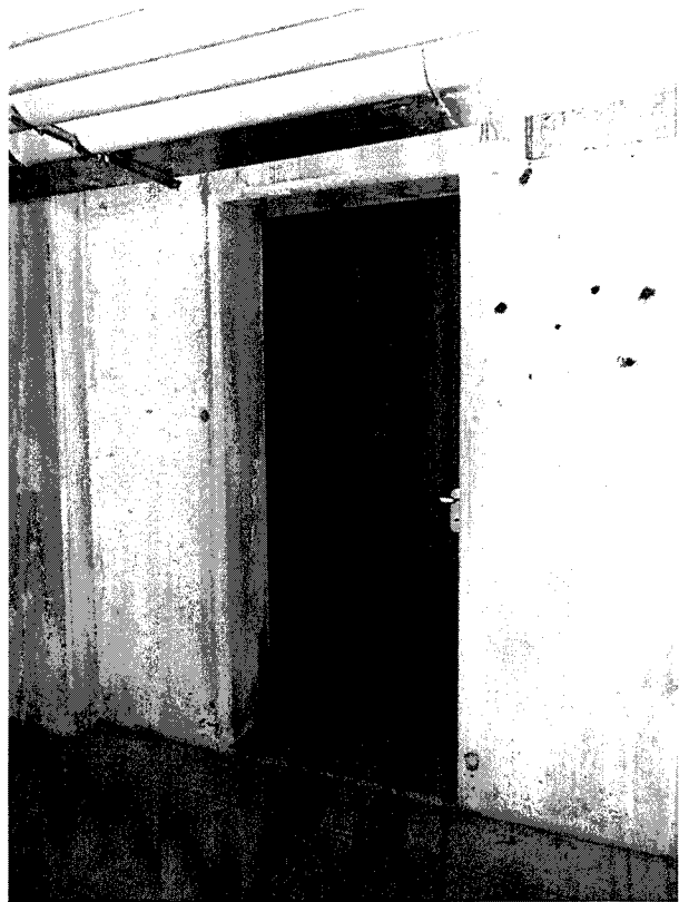
Foto 8: porta d'accesso all'appartamento al piano sotterraneo
