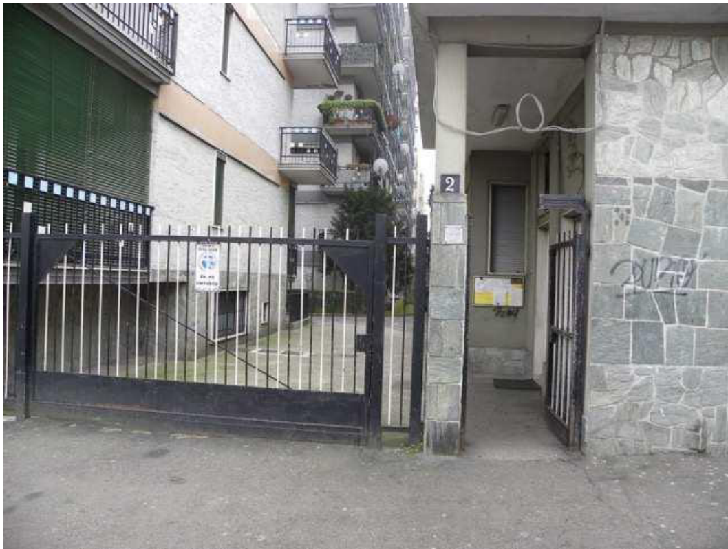
Cancello di Accesso al Fabbricato
