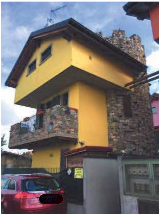
2. Villetta oggetto di E.I., vista lato sud-est.
