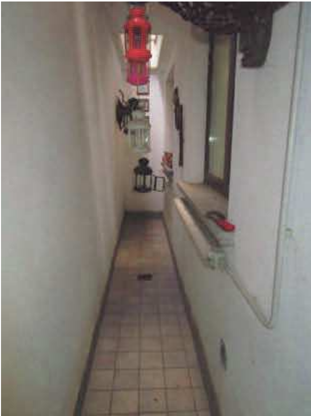
49. Intercapedine contro terra al piano seminterrato.
