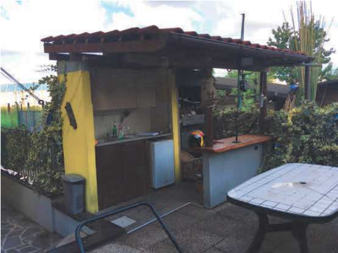
14. Costruzione per area barbeque.
