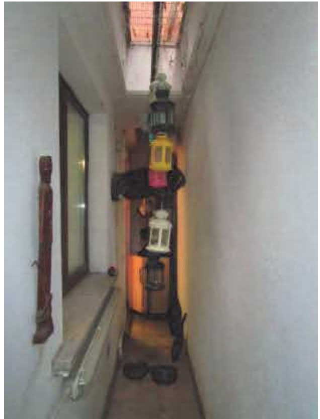
50. Intercapedine contro terra al piano seminterrato.
