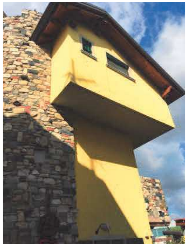
7. Villetta oggetto di E.I., vista lato sud-ovest.
