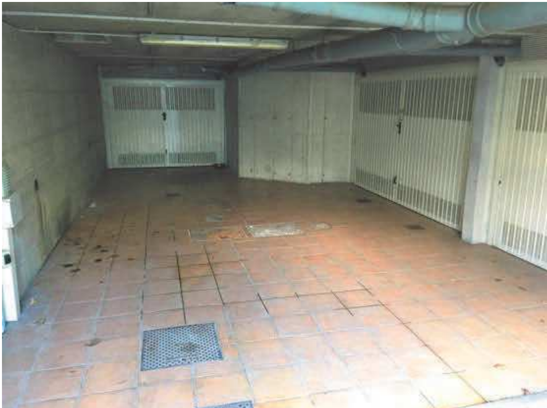
55. Corsello dei boxes.
