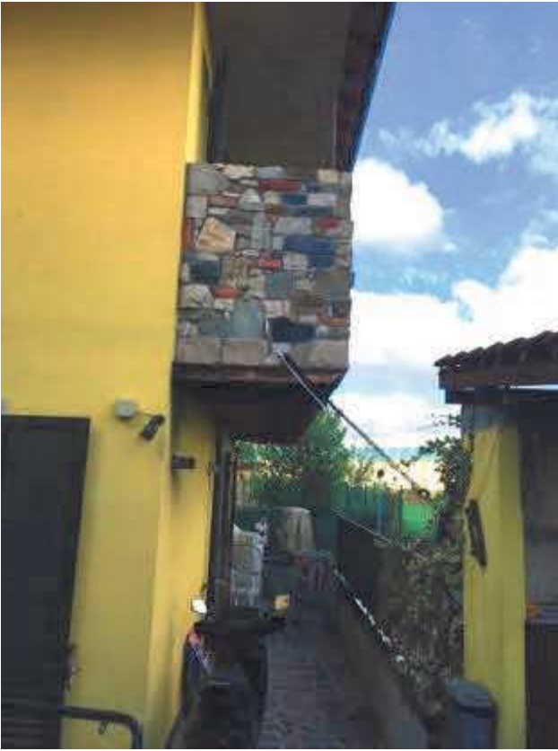
11. Area cortilizia lato nord.
