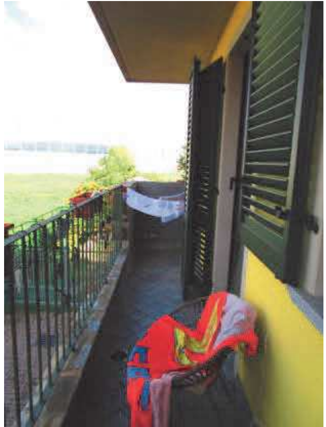
33. Balcone piano primo.
