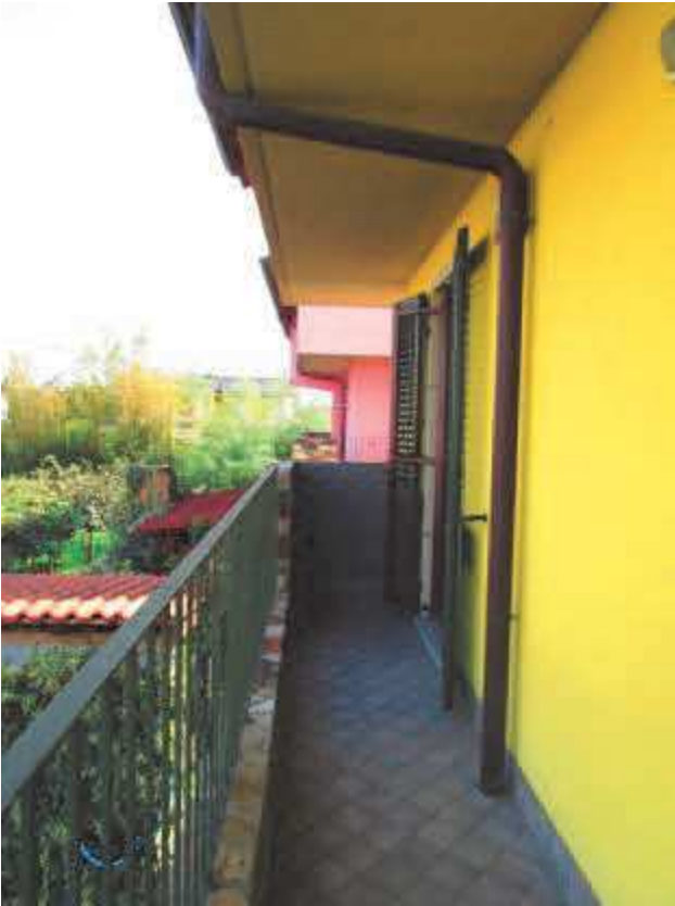
32. Balcone piano primo.
