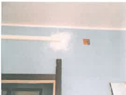
25. Cavidotti per il condizionamento
