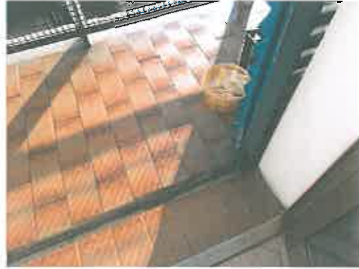
32. Pavimento del balcone
