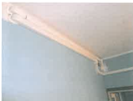
26. Cavidotti per il condizionamento
