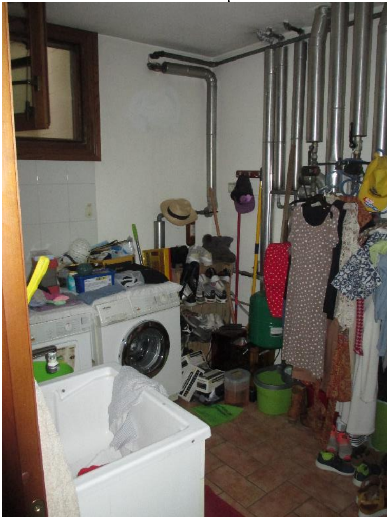
Foto 22: locale cantina destinato a locale caldaia e lavanderia
