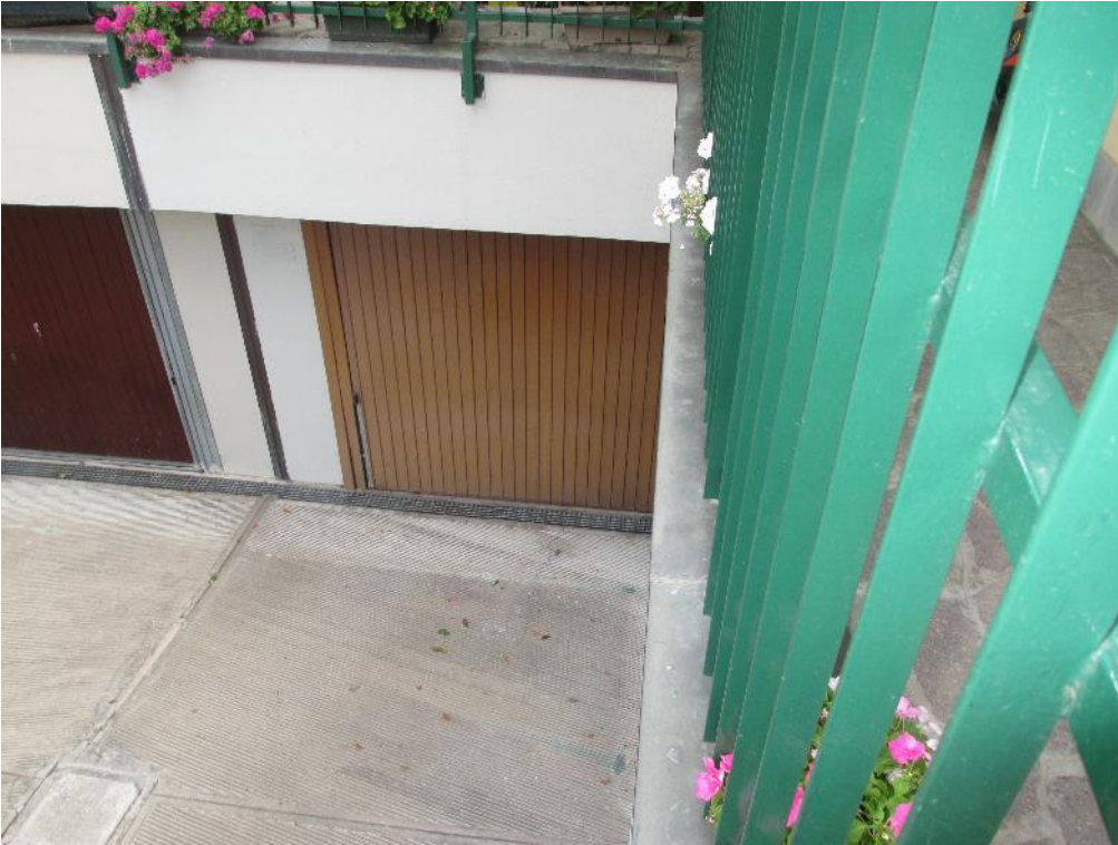
Foto 29: box chiuso – vista da giardino interno
