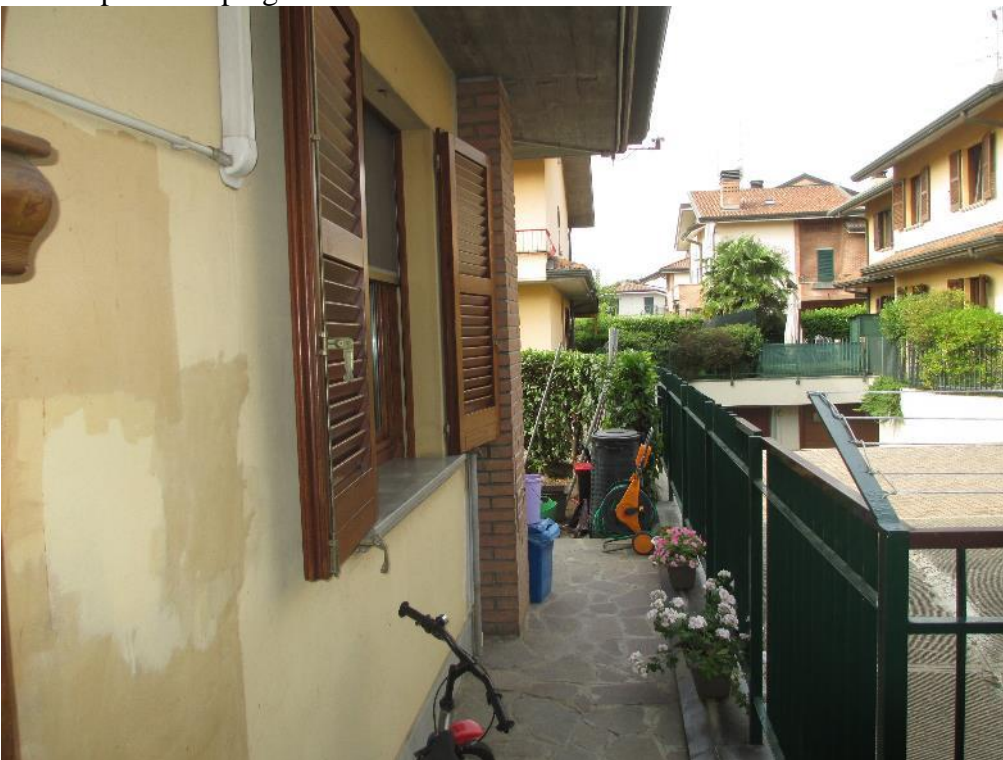
Foto 4: passaggio verso giardino interno
