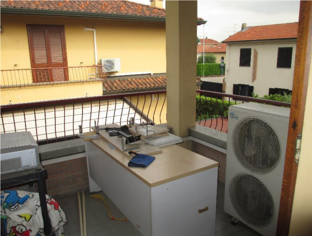
Foto 19: balcone piano primo
