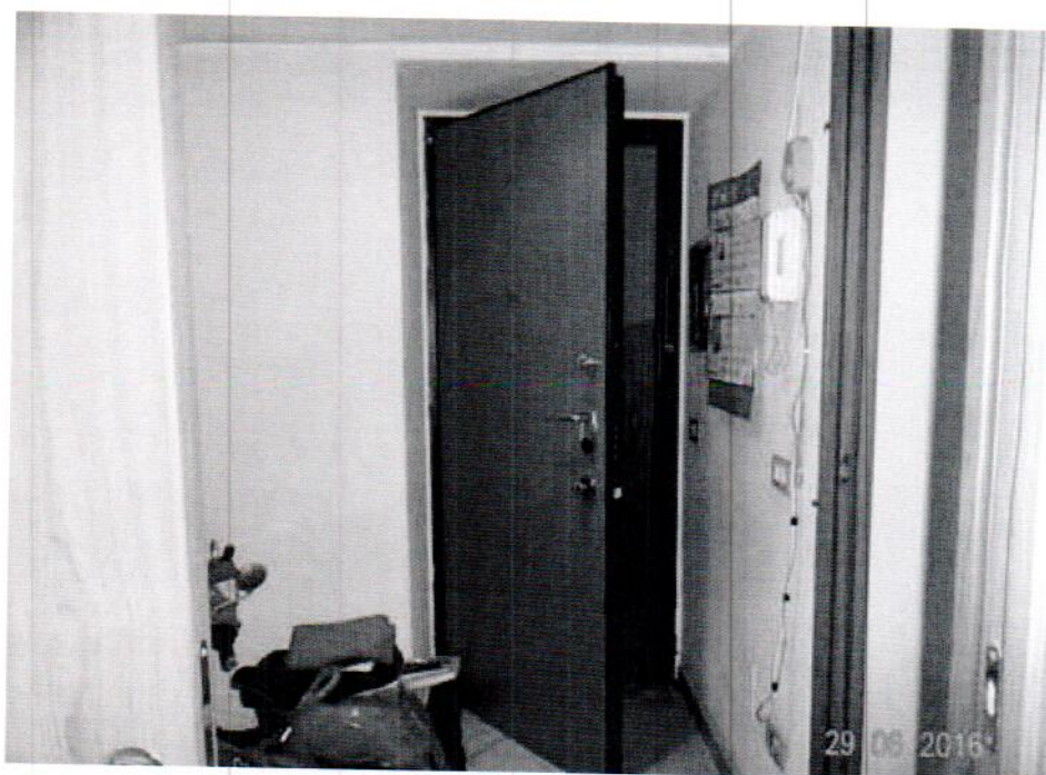
Vista interna - ingresso unità abitativa
