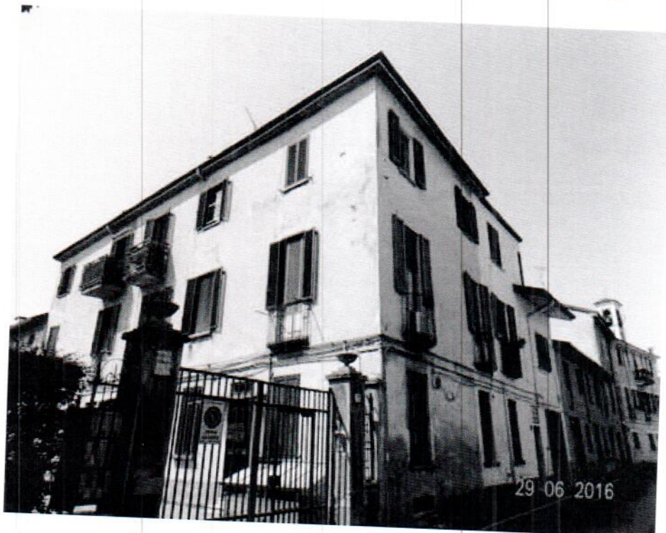
Vista esterna - ingresso pedonale e carroio fronte strada
