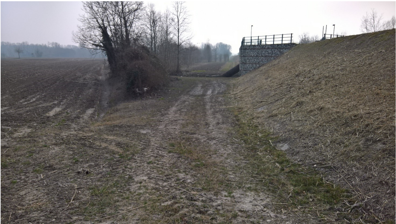
Foto n. 3 – LOTTO 4 - Comune di Morsano al Tagliamento (PN) – Frazione Mussons – foglio 25 Particella 699 – Veduta del percorso freccia blu di cui alla foto precedente, che conduce alla particella 699.
